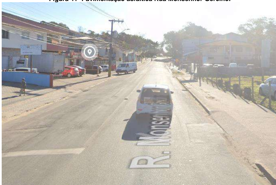
Figura 41- Pavimentação asfáltica Rua Monsenhor Gercino.
