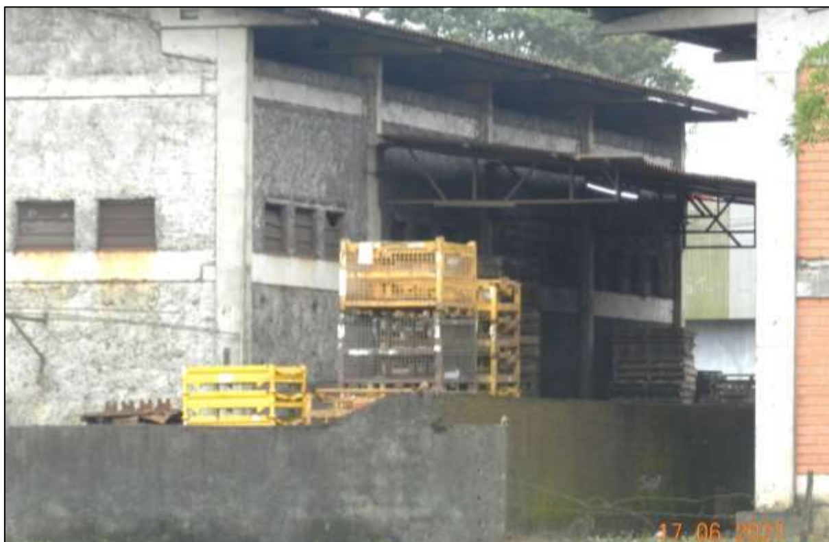
Figura 44. Empreendimento de uso industrial. Fonte: DBio, 2021.
