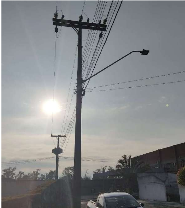
Figura 52 – Sistema de iluminação pública localizado na Rua Jequié
