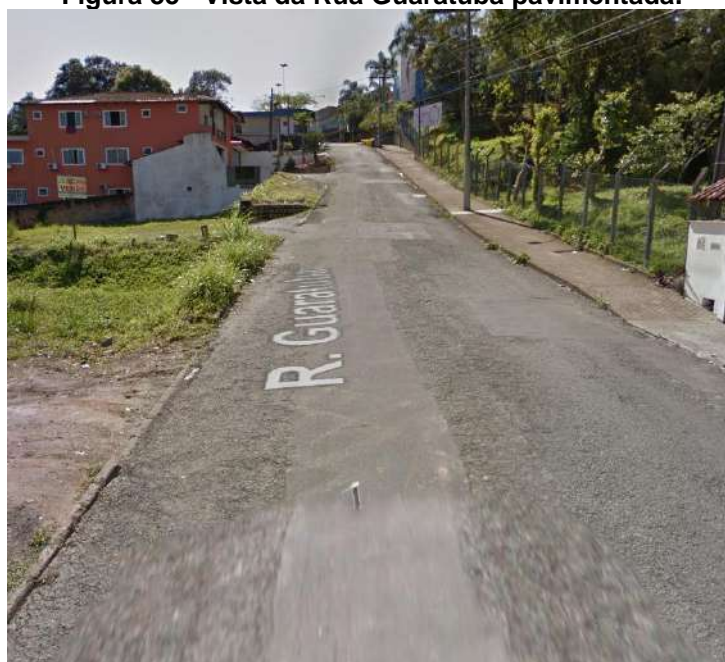
Figura 35 - Vista da Rua Guaratuba pavimentada.
