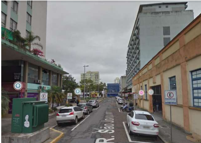
Figura 28 - Rede de abastecimento de energia elétrica subterrânea.
