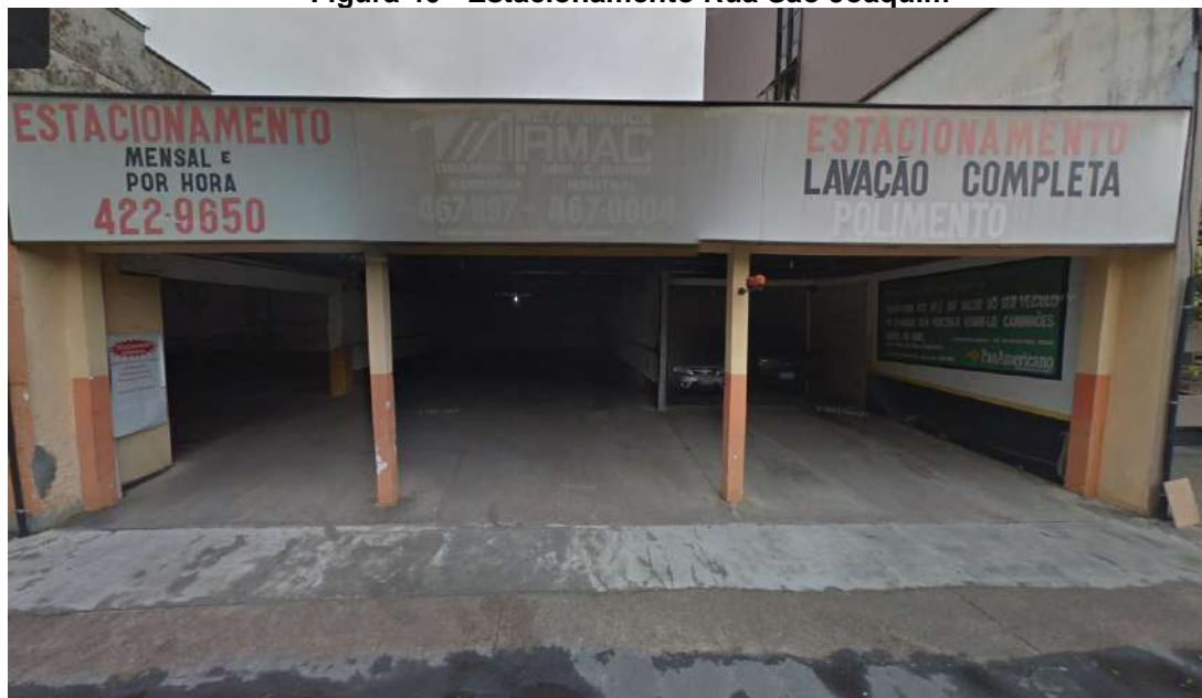
Figura 40 - Estacionamento Rua São Joaquim
