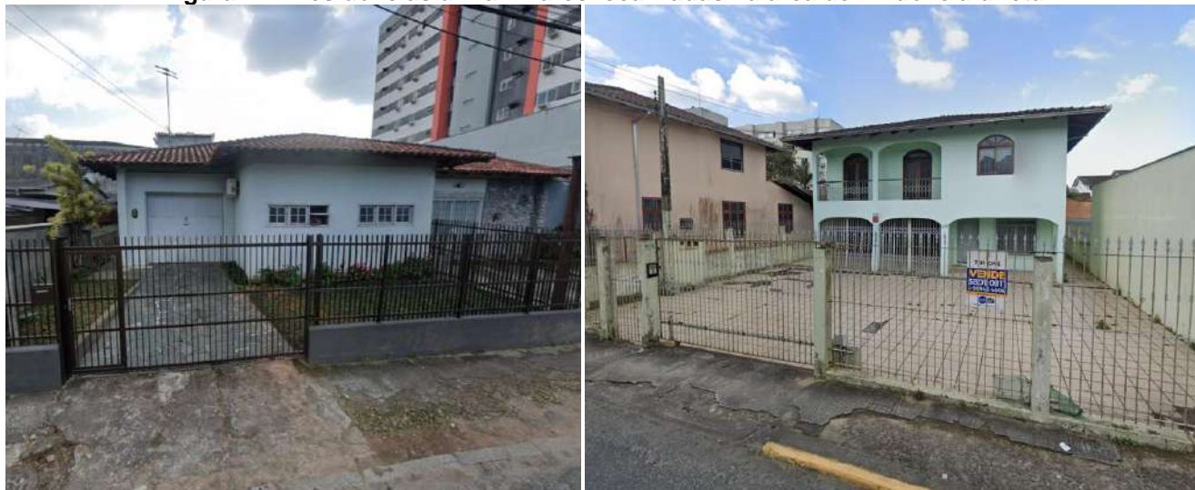
Figura 12 - Residências unifamiliares localizadas na área de influência direta
