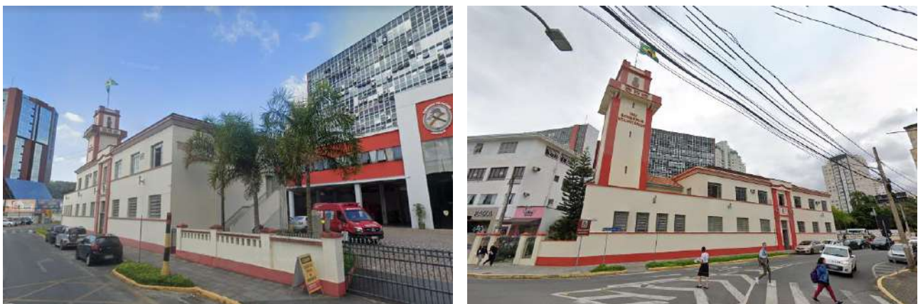
Figura 60 – Visuais da Sede do Corpo de Bombeiros
