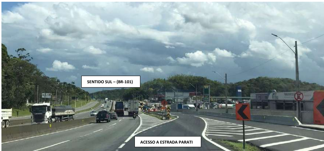
Foto 39 – Principal acesso pela (BR-101).
