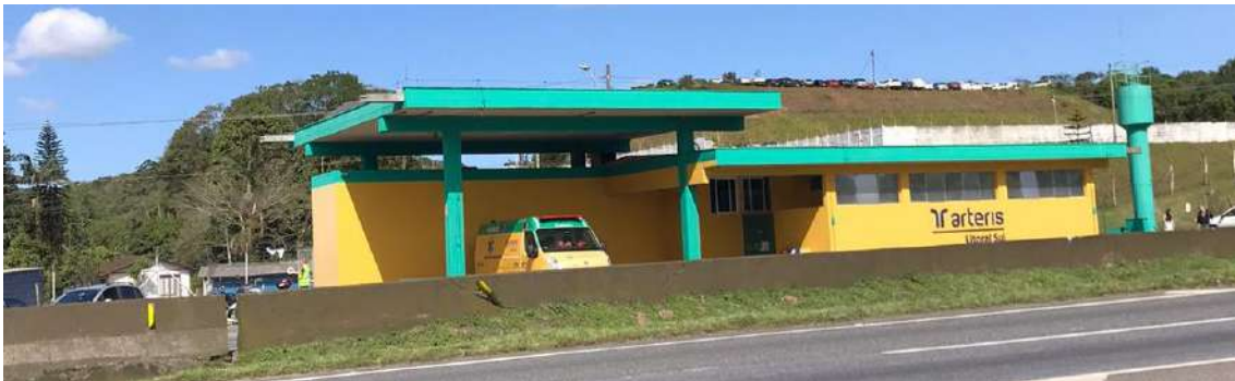
Figura 20 – Autopista Litoral sul próximo ao futuro empreendimento.
