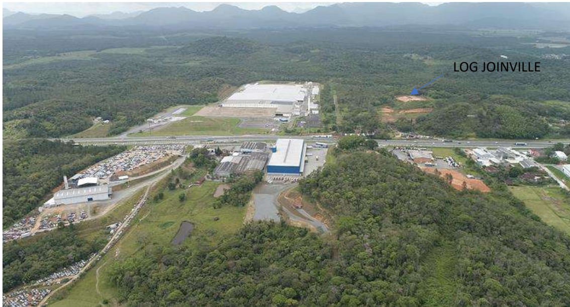
Foto 38: Vista geral de frente do imóvel
