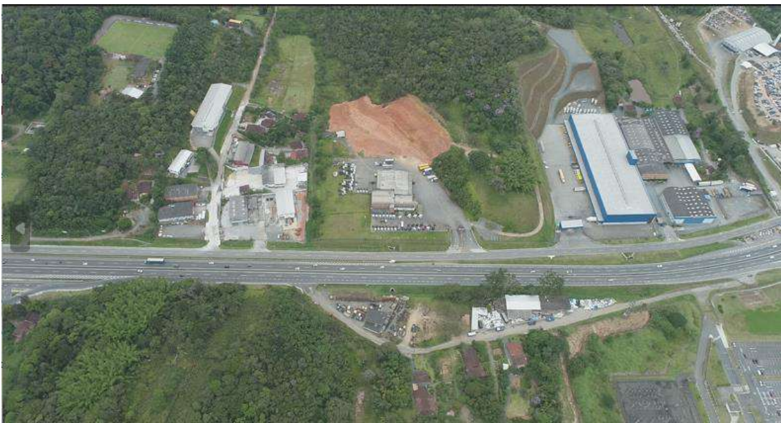
Foto 36 Vista edificações sentido Leste
