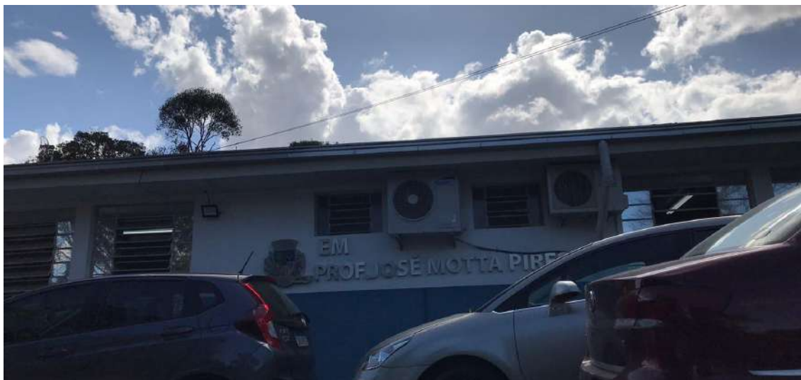
Foto 17 – Escola Municipal Professor José Motta Pires - mais próxima do empreendimento.
