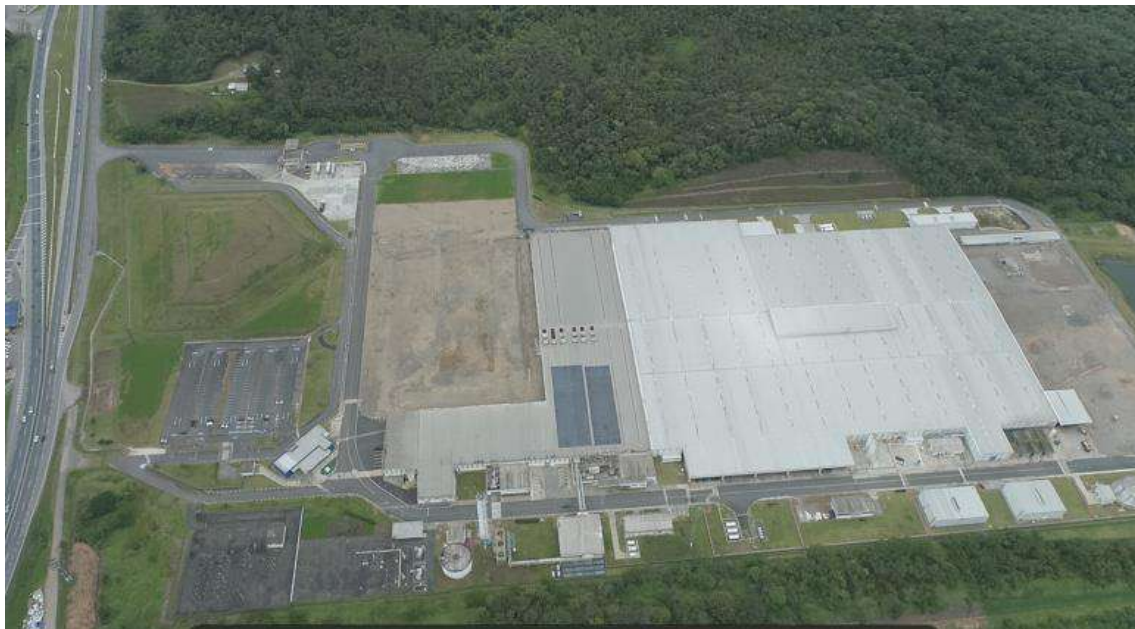
Foto 32: Imagem vista Sul – Fábrica da GM
