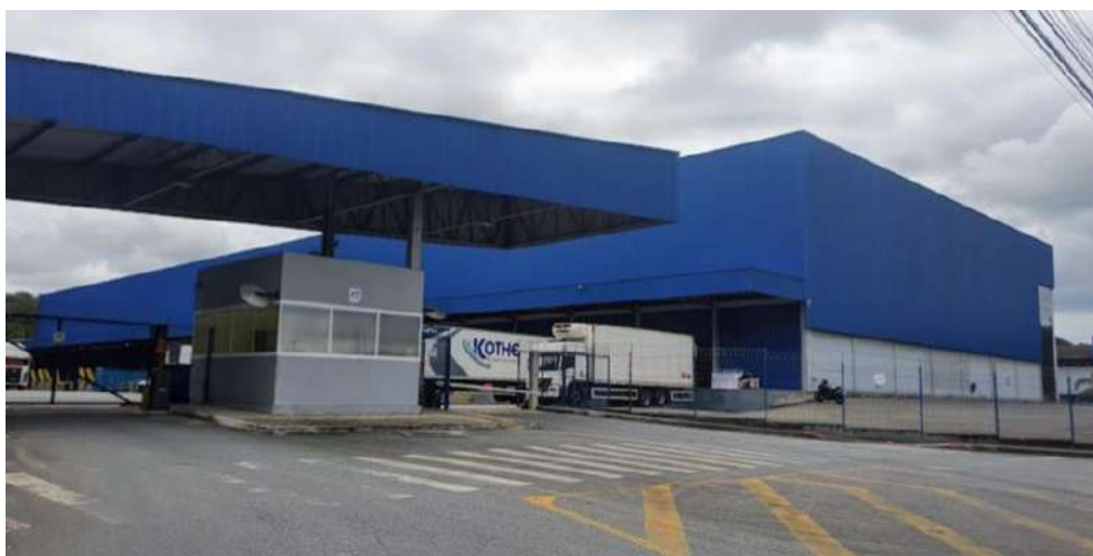
Foto 07: Terminal de carga em frente ao empreendimento
