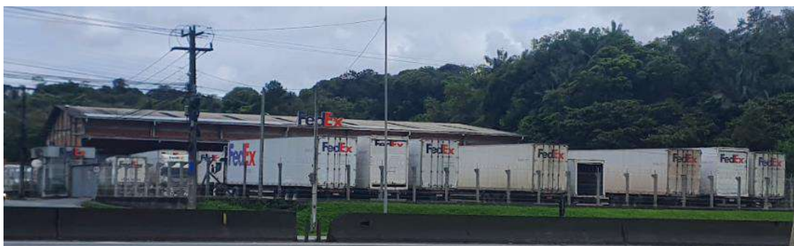
Foto 06: Centro logístico da Fedex próximo ao empreendimento
