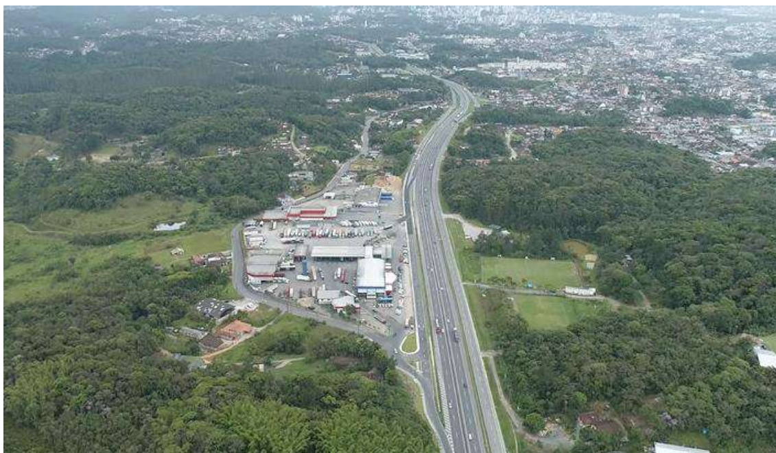
Foto 44: Vista da BR 101 – vista Norte
