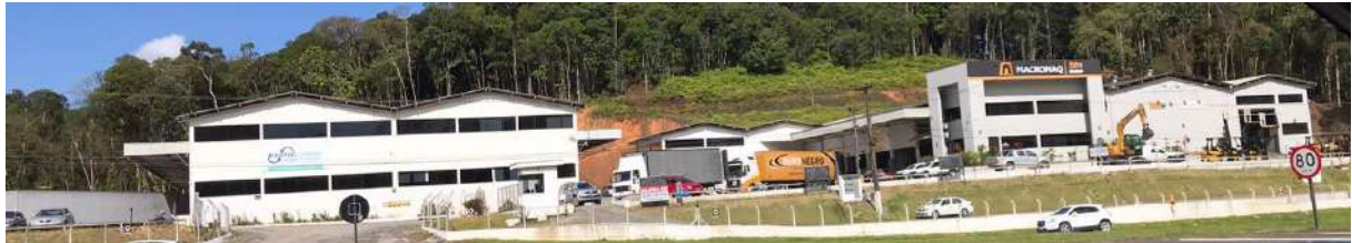
Foto 25 – serviço próximo ao empreendimento.
