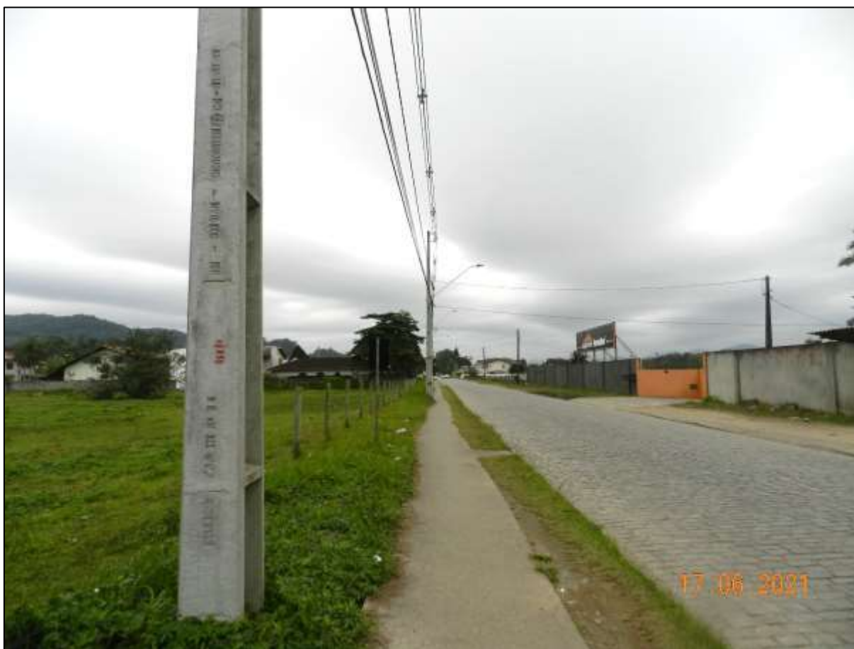
Figura 57: Rede elétrica passando pela Rua Dorothovio do Nascimento rua de acesso ao imóvel. Fonte: DBio, 2021.
