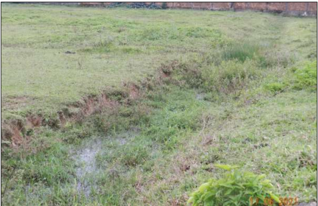
Figura 18. Detalhamento de uma das valas de drenagem observada no imóvel em estudo. Fonte: DBio, 2021.
