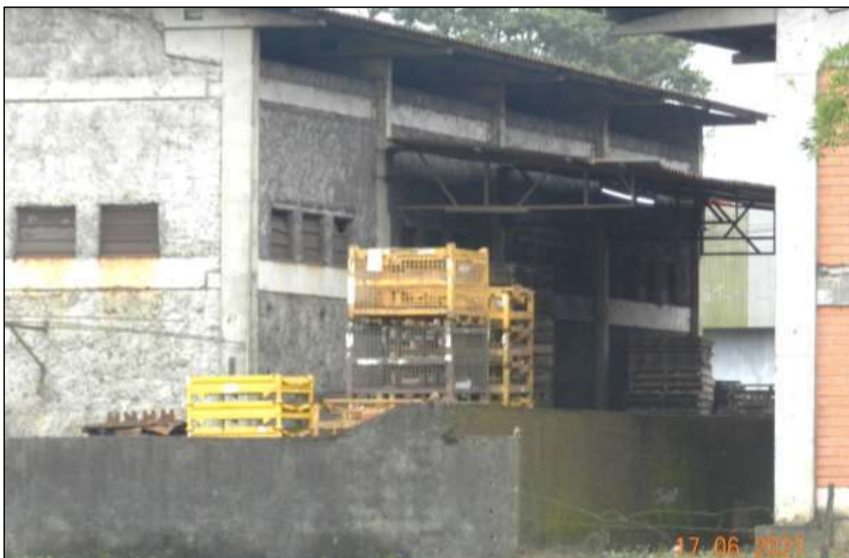
Figura 44. Empreendimento de uso industrial. Fonte: DBio, 2021.
