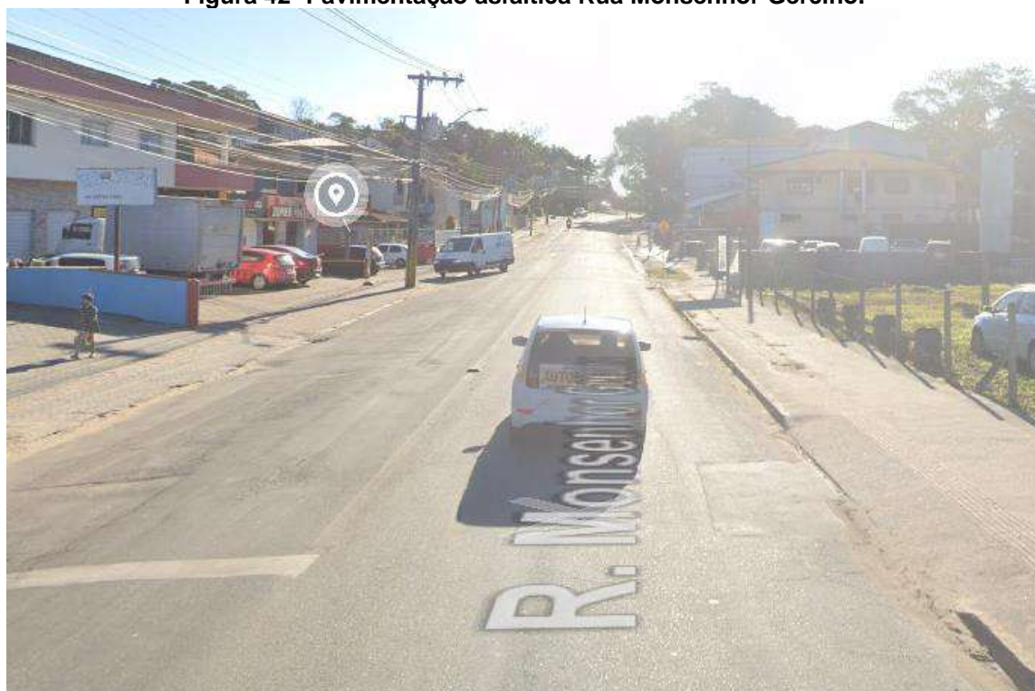
Figura 42- Pavimentação asfáltica Rua Monsenhor Gercino.
