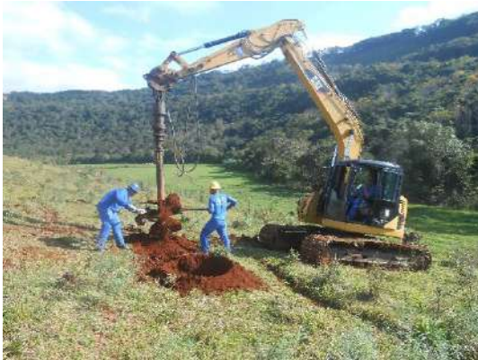
Figura 12: Exemplo de escavação do tipo tubulão.
