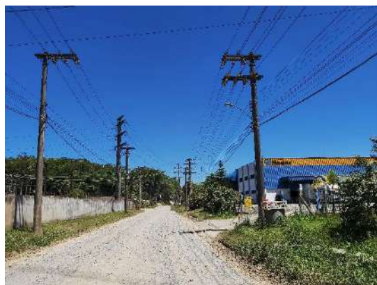
Figura 21: Rua Santa Catarina acesso da Subestação Joinville Santa Catarina.
