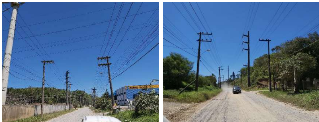
Figura 54: Estruturas existentes na área urbana transpassada pela LD.
