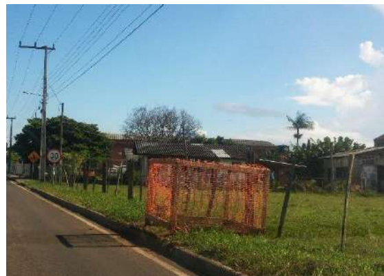
Figura 15: Área de fundação sinalizada.
