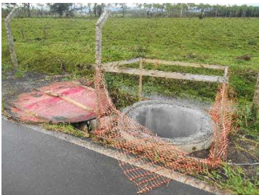
Figura 14: Exemplo de fundação para poste.
