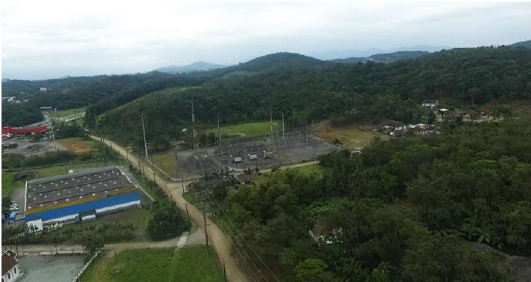
Figura 27: Área de chegada da linha na Subestação Joinville Santa Catarina (primeiro plano), composta pela unidade de Gnaisses Granulíticos Luís Alves, caracterizado pela presença de morrotes e morros baixos (segundo plano).
