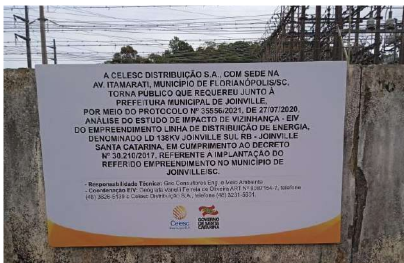
Figura 1: Placa informativa de implantação do empreendimento instalada na fachada da Subestação Joinville Santa Catarina.
