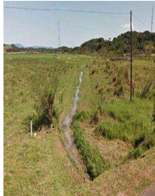
Figura 40: Afluente não retificado de 1º ordem paralelo a BR-101 (trecho final). Fonte: Geo Consultores, 2020.
