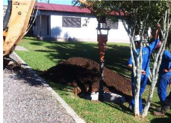
Figura 13: Exemplo de escavação para poste.
