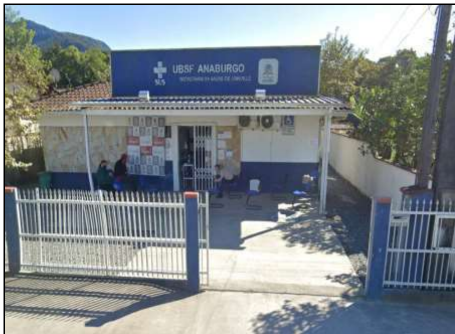
Figura 32: UBSF – Estrada Anaburgo. Fonte: Google Earth, 2022.
