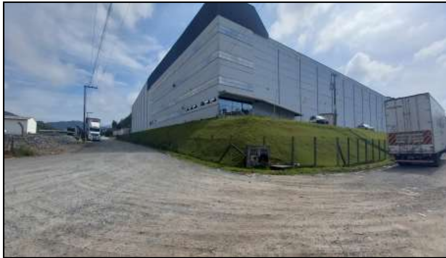
Figura 07: Rua dos Bororós, entrada para o futuro empreendimento. Autor Quasa Ambiental, 2022.
