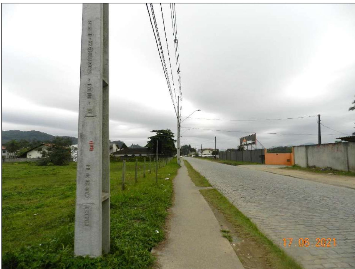
Figura 56: Rede elétrica passando pela Rua Dorothovio do Nascimento rua de acesso ao imóvel. Fonte: DBio, 2021.
