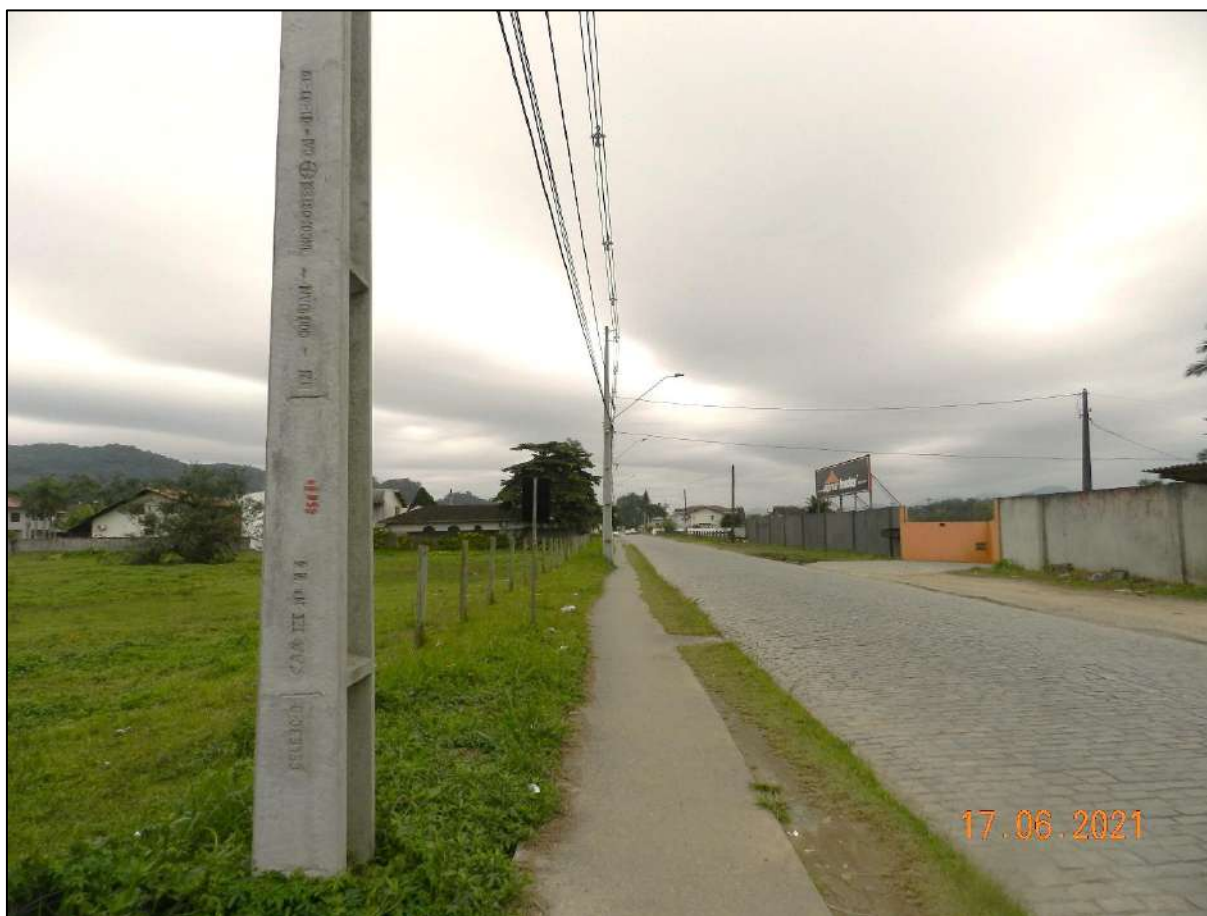
Figura 65. Rua Dorothovio do Nascimento evidenciando pavimentação. Fonte: DBio, 2022.
