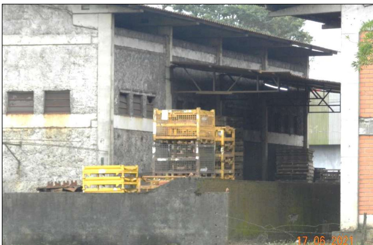
Figura 43. Empreendimento de uso industrial. Fonte: DBio, 2021.
