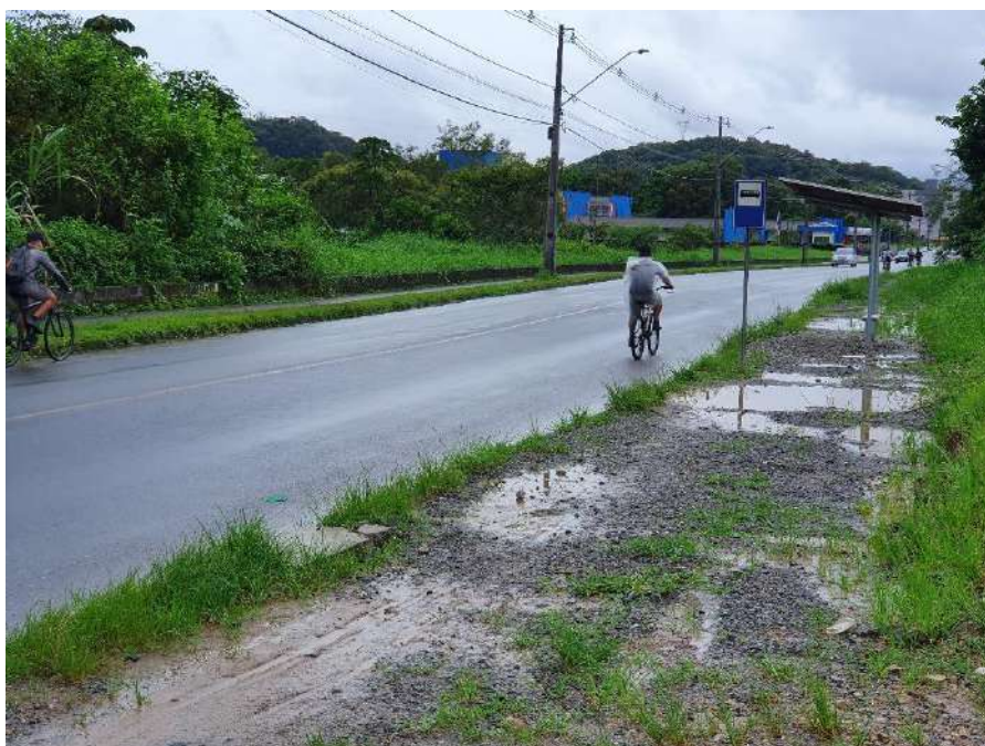
Figura 133: Rua Rolando Gurske, próximo a Rua Paulo Schneider
