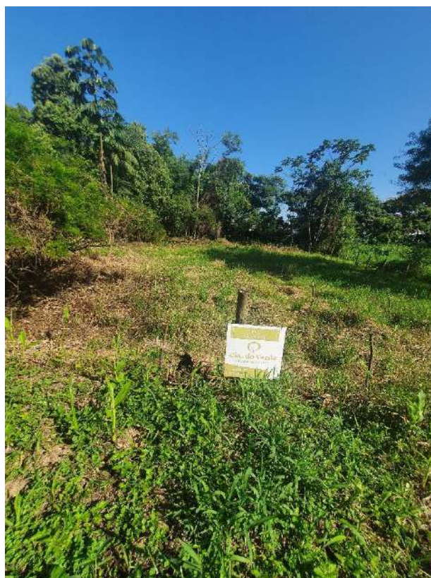
Figura 72: Execução do PRAD na área de APP
