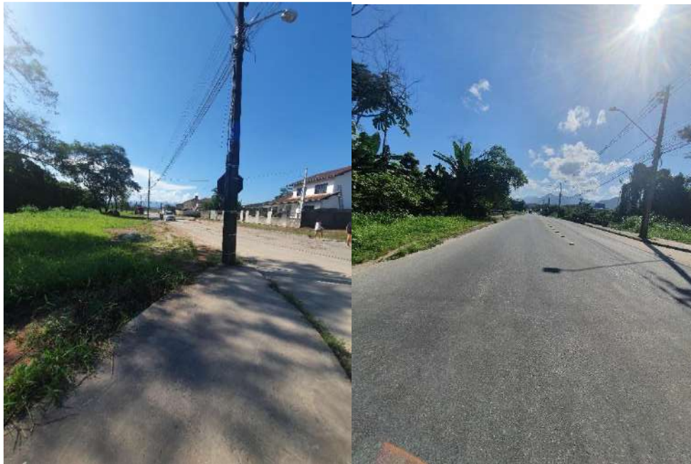
Figuras 90 e 91: Iluminação Pública em frente ao empreendimento
