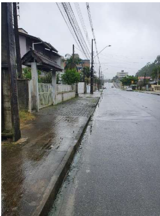
Figura 79: Asfaltos e passeios da rua Rolando Gurske
