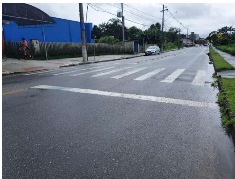
Figura 77: Faixa de pedestre em frente ao imóvel
