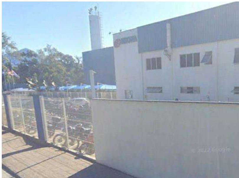
Figura 116: Indústria Krona – rua dos Suíços próximo ao empreendimento
