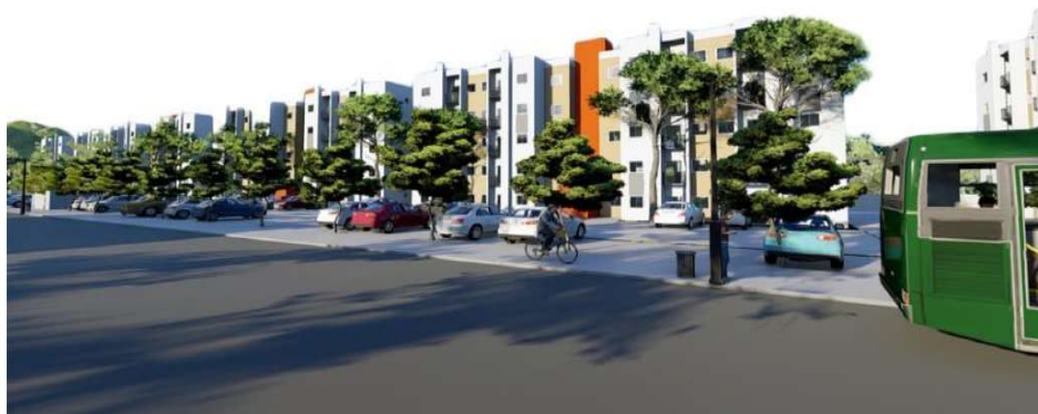
Figura 107: Skyline do futuro empreendimento
