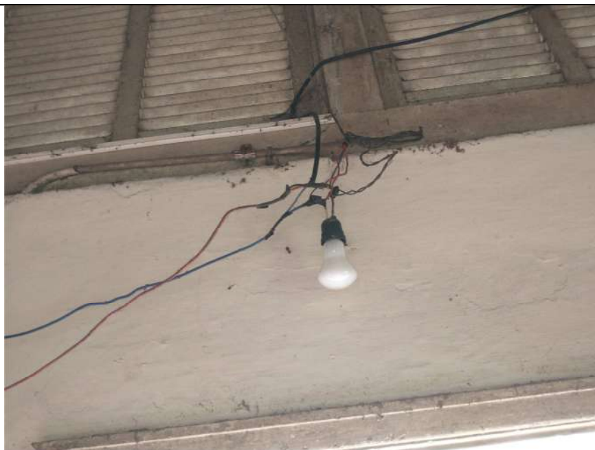
Imagem 05 – Detalhe das instalações elétricas que não atendem às normas técnicas de segurança.
