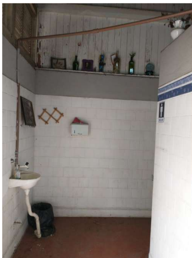
Imagem 06 – Detalhe das instalações hidrossanitárias do sanitário masculino, que não atendem às normas técnicas.
