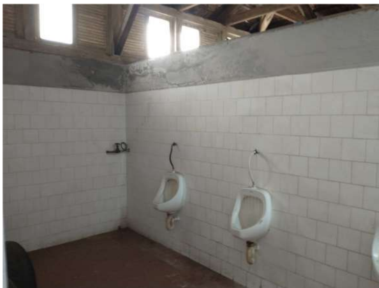
Imagem 07 – Vista interna com detalhe dos únicos equipamentos no interior do sanit. Masculino (mictórios). Ausência de forro e de divisória até o teto entre os sanitários.
