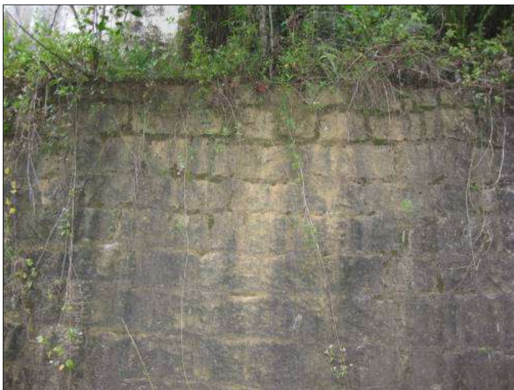
Foto 2.25 - Detalhe de fluxo superficial sobre o muro existente.
