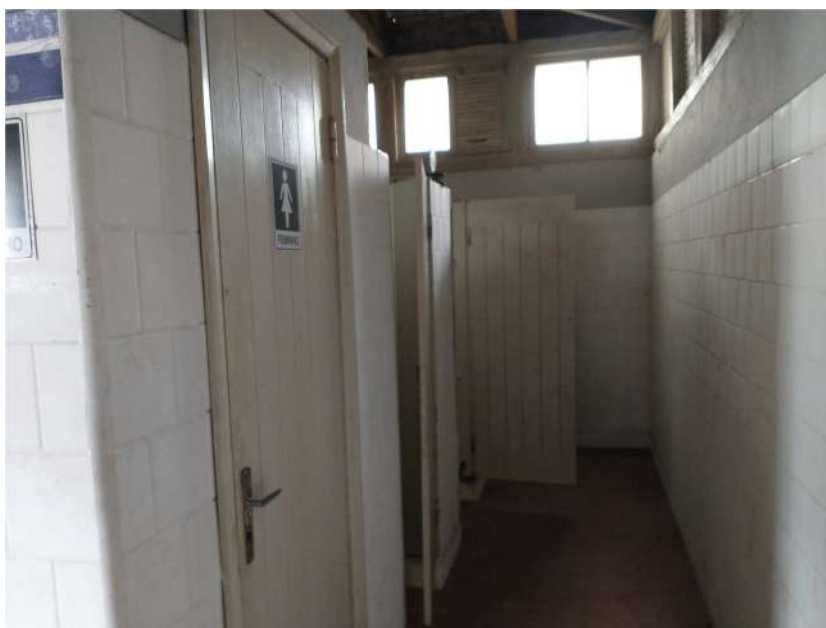
Imagem10 – Vista interna com detalhe das cabines do sanitário feminino sem acessibilidade e com ausência de pias.
