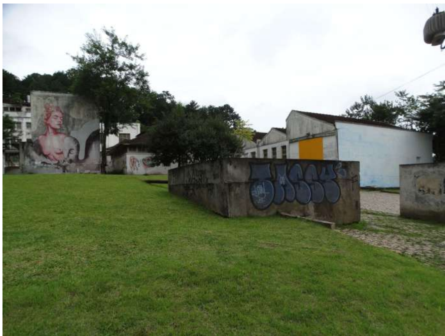
Imagem 069: Antigo depósito de sobras de cevada que era distribuída à população para alimentação de animais Nível de Preservação: LIBERADO (Aprovado na COMPHAAN em 14/07/2010, ata 134/2010) Aspectos construtivos: Não relevante Uso atual: SEM USO Estado de conservação: Não relevante Fonte: CPC/SECULT, 18/04/2022
