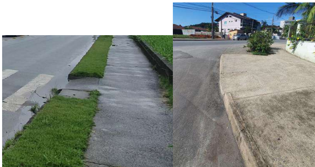
Figuras 92 e 93: Pavimentação de asfalto, passeios e área de acessibilidade no local
