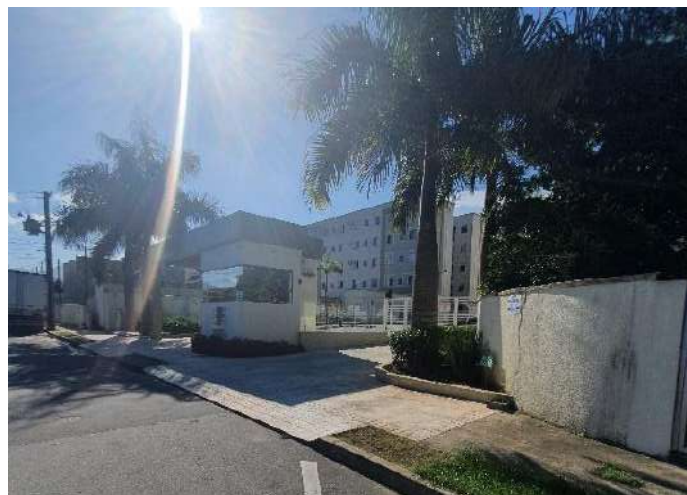
Figura 10: Condomínio residencial Jardim Luxemburgo
