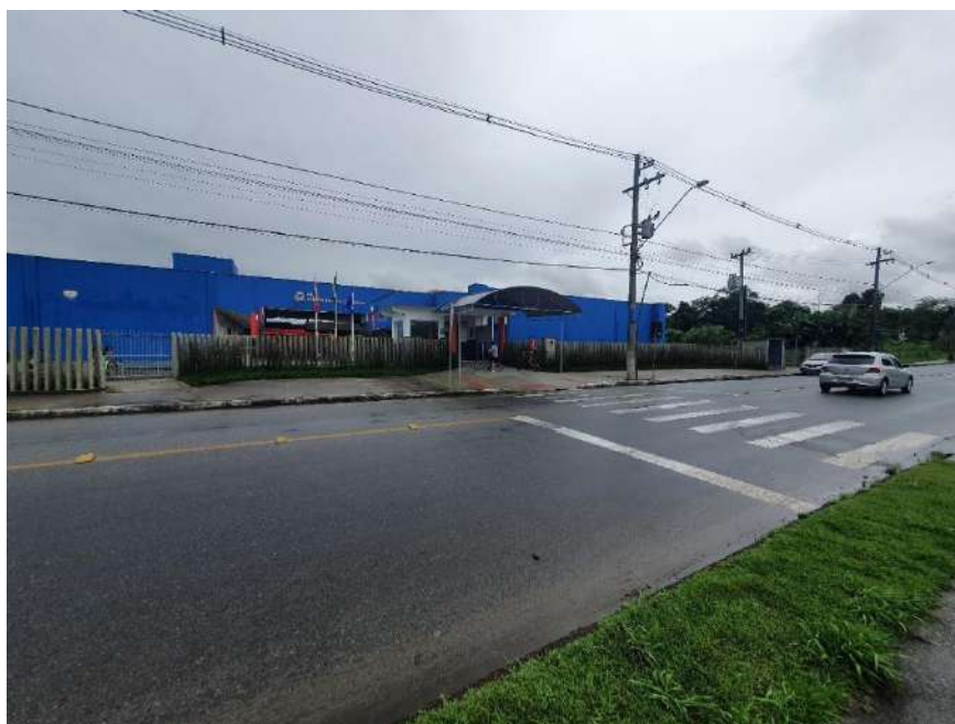
Figura 80: Escola municipal em frente ao empreendimento
