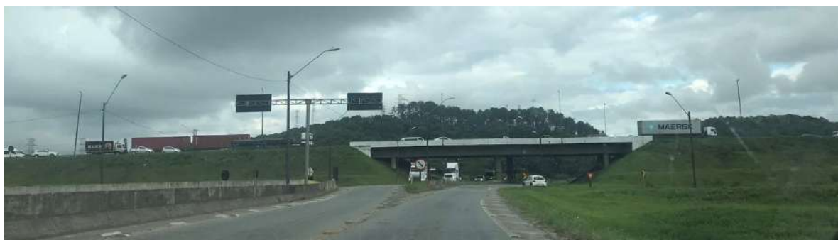
Figura 99: Acesso próximo a BR 101
