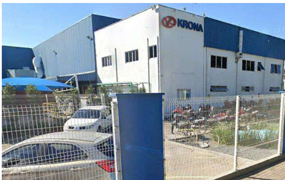
Figura 75: Fábrica da Kroma – rua dos Suíços
