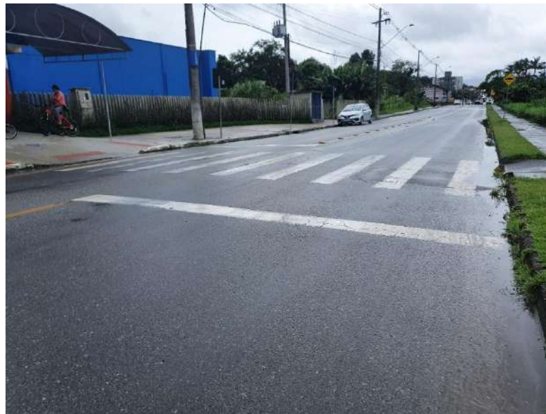
Figura 77: Faixa de pedestre em frente ao imóvel
