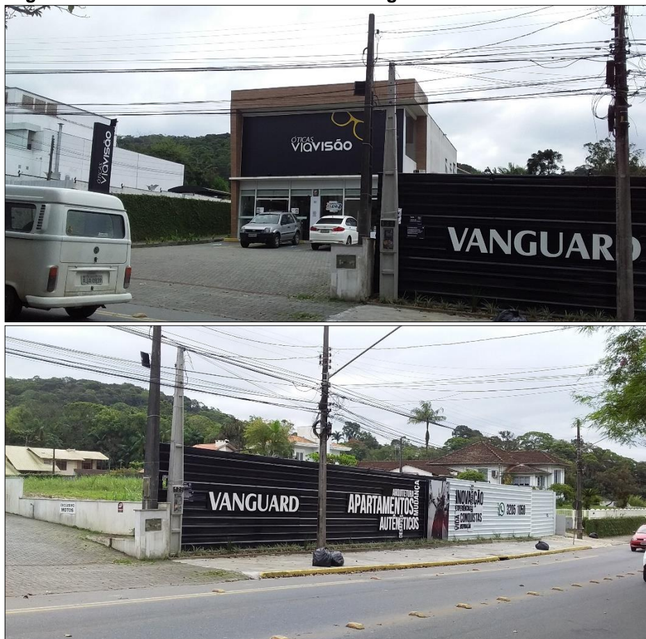
Figura 61 - Rede de abastecimento de energia elétrica na Rua Camboriú.
