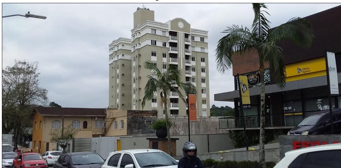
Fonte: AMBIENT Engenharia e Consultoria, 2020.
