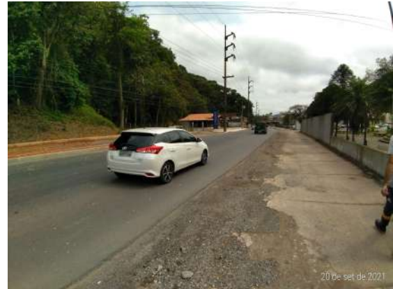
Figura 27: Trecho tubulado sob via pública - Rua Pref. Helmuth Fallgatter
