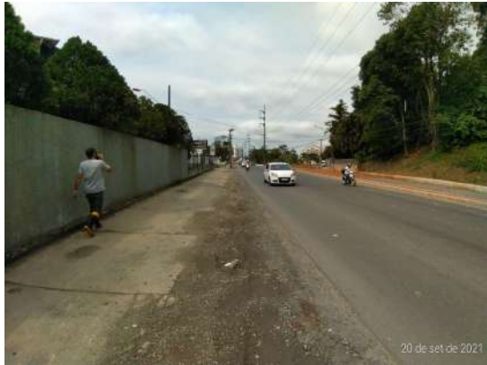
Figura 26: Trecho tubulado sob via pública - Rua Pref. Helmuth Fallgatter
