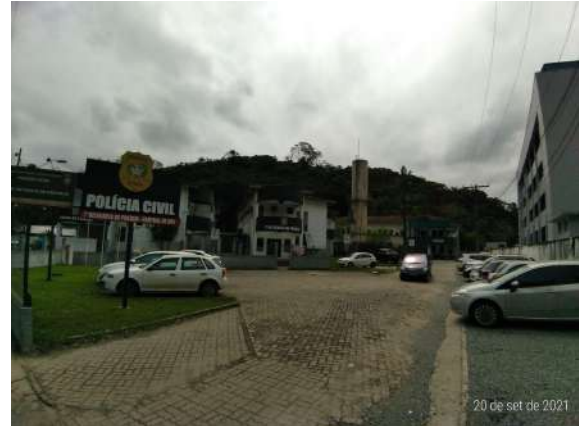
Figura 24: Construções e pavimentação sobre corpo d'água tubulado
