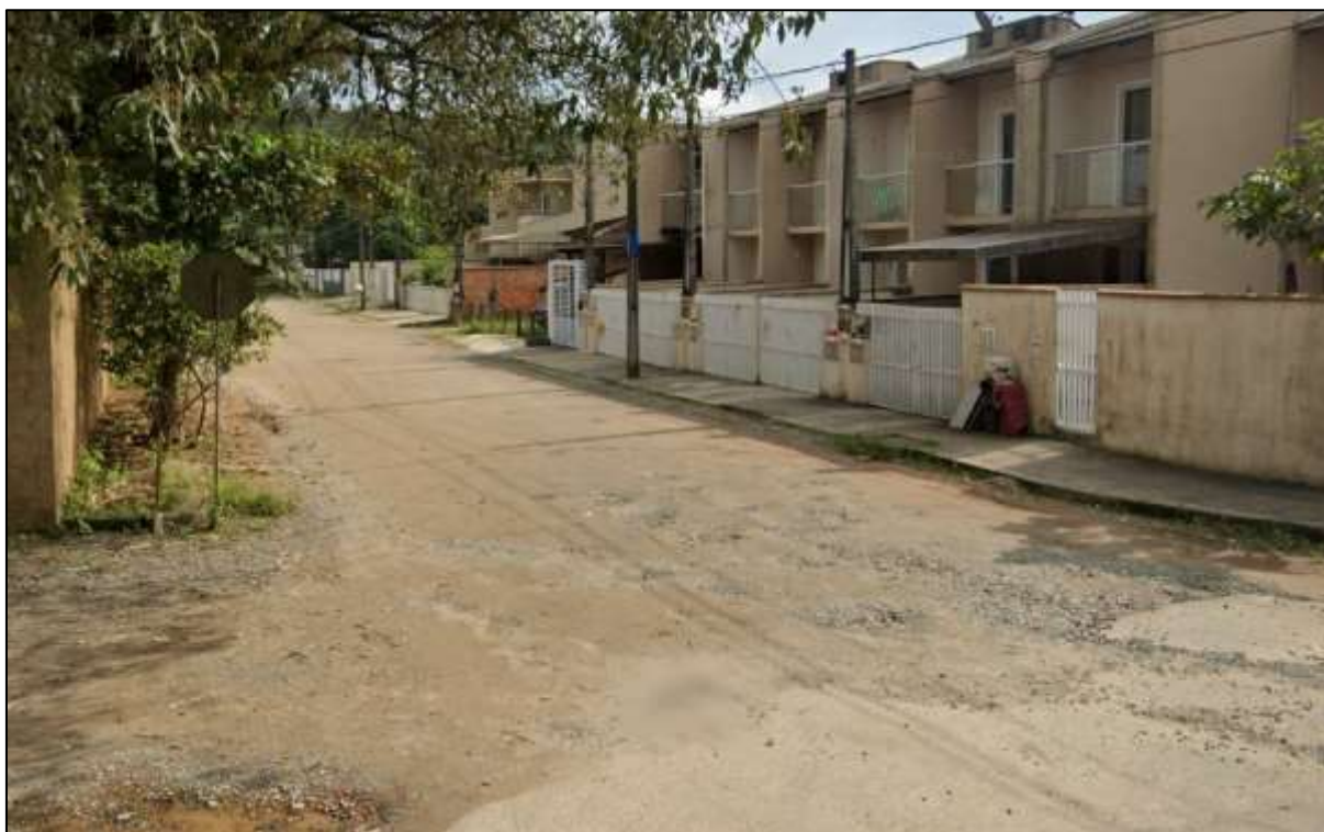
Figura 52: Prolongamento da Rua Hilda Rech, sem pavimentação. Autor: DBio, 2021.
