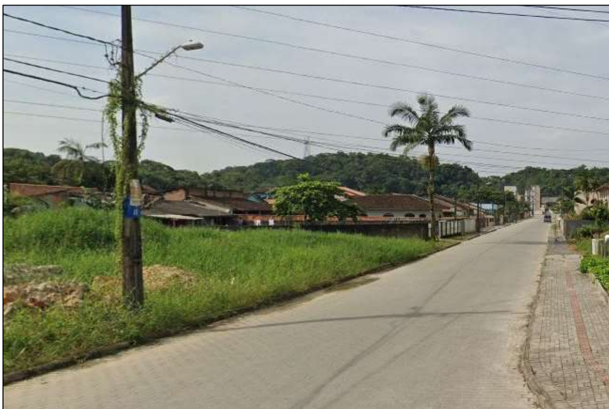
Figura 51: Prolongamento da Rua Hilda Rech pavimentada. Autor: DBio, 2021.
