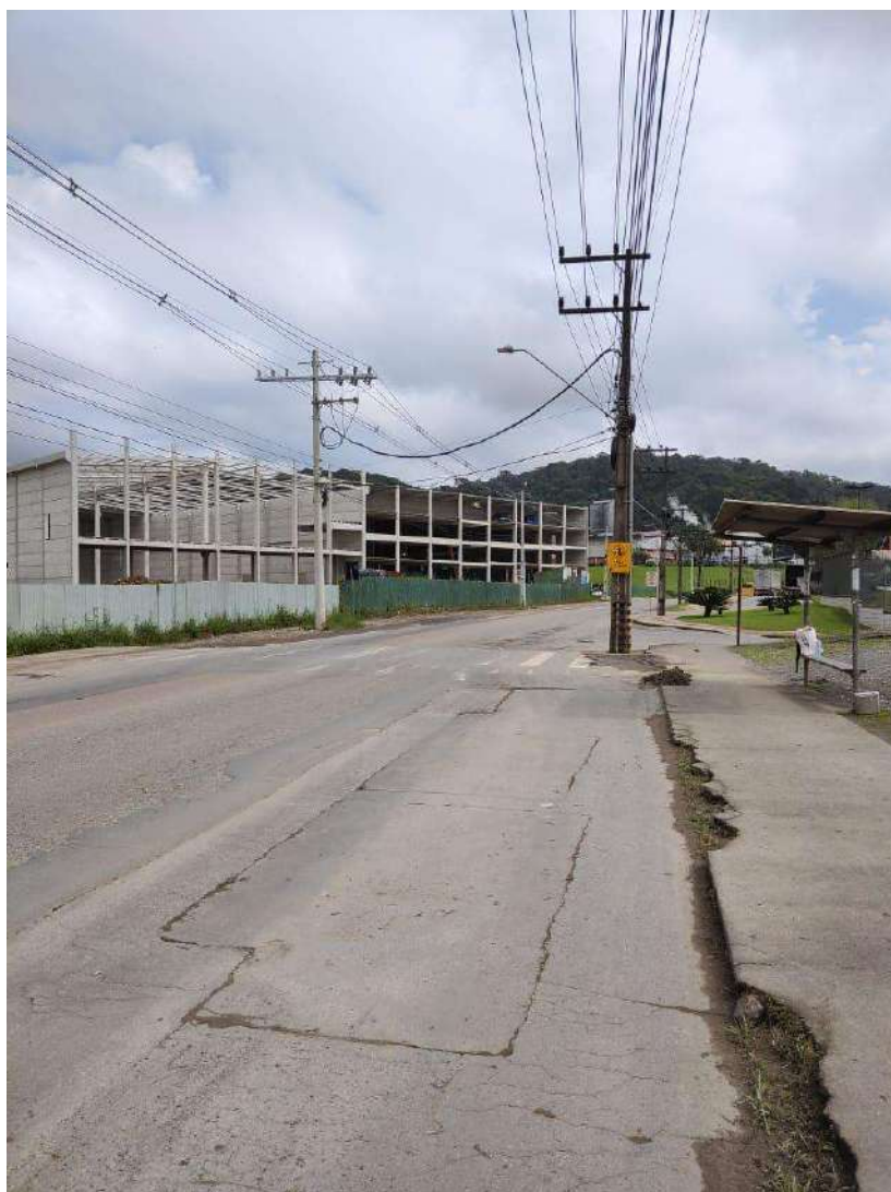
Figura 17 - Calçada na Rua Dona Francisca em frente ao imóvel
