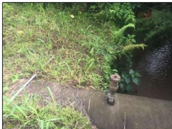
**Figura 2.1.2:** Seta indicando a passagem da tubulação da rede de alta pressão.
