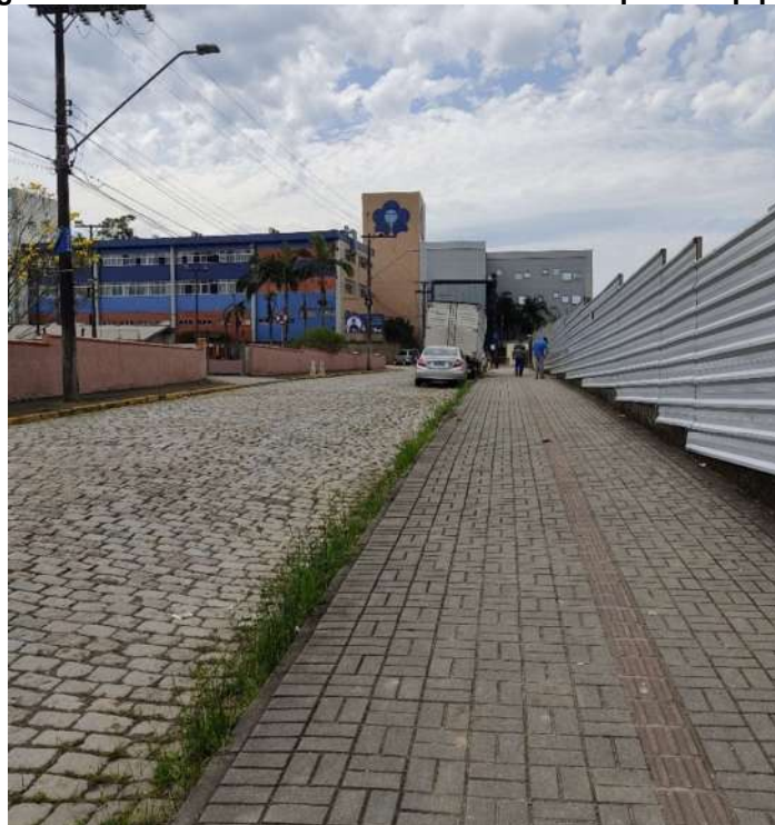
Figura 47 – Vista da Rua Frederico Ponick em paralelepípedo.
