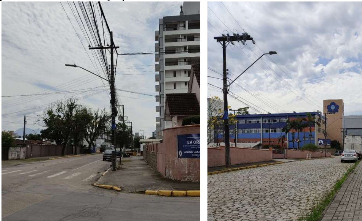
Figura 49 – Sistema de iluminação pública localizado na Rua Dona Francisca e Rua Frederico Ponick.
