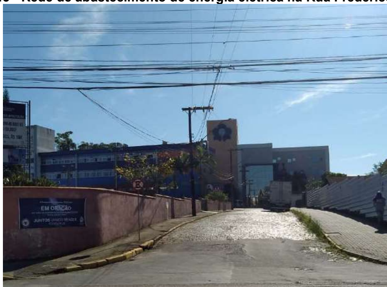
Figura 43 - Rede de abastecimento de energia elétrica na Rua Frederico Ponick.
