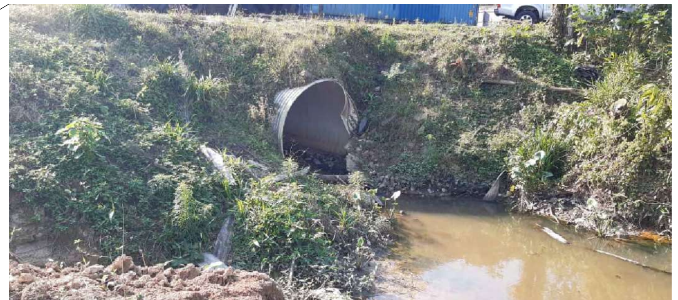
TUBULAÇÃO EXISTENTE DE \varnothing=2,30\text{m} NA ÁREA DA ASCENSUS, QUE SERÁ CONECTADA NA CAIXA DE DRENAGEM PROJETADA.
