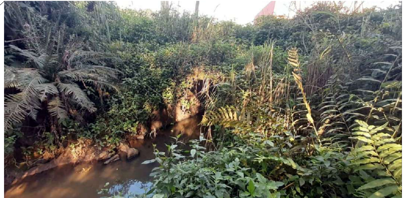
SAÍDA DA GALERIA PLUVIAL EXISTENTE SOB A AV. EDGAR NELSON MEISTER QUE CONDUZ A DRENAGEM PLUVIAL AO RIO RITTER.
