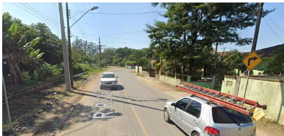
Figura 99: Pavimentação no entorno do empreendimento
