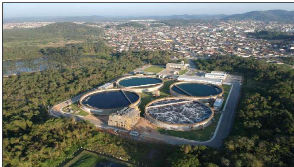
Figura 7: Foto aérea ETE Jarivatuba
