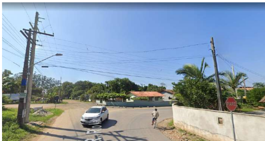
Figura 95: Iluminação pública na rua Rio Velho
