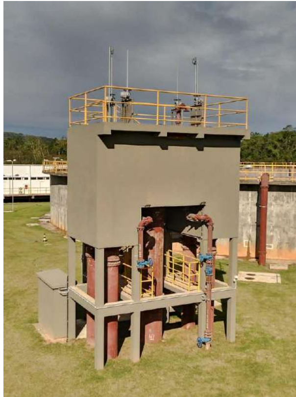
Figura 24: Tanque de distribuição
