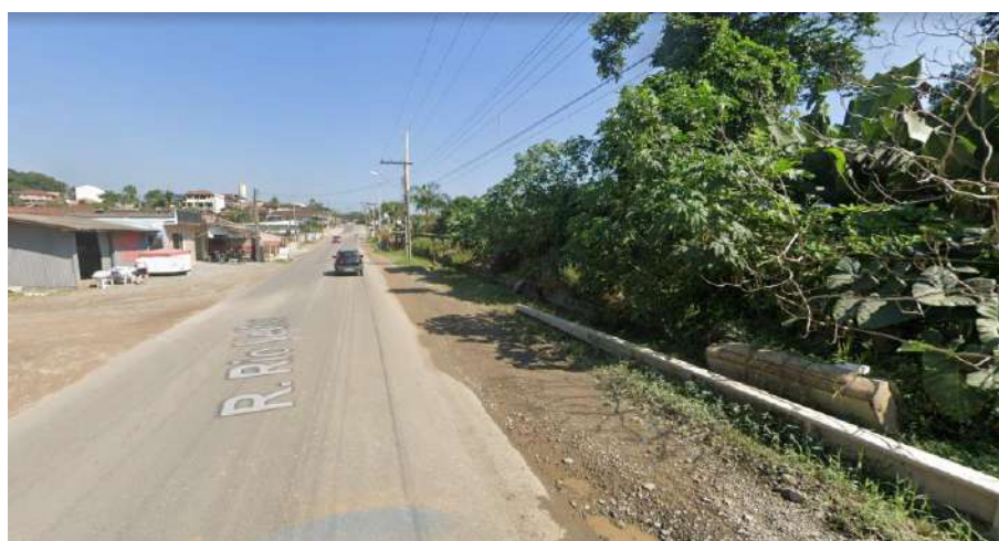
Figura 96: Iluminação pública na rua Rio Velho
