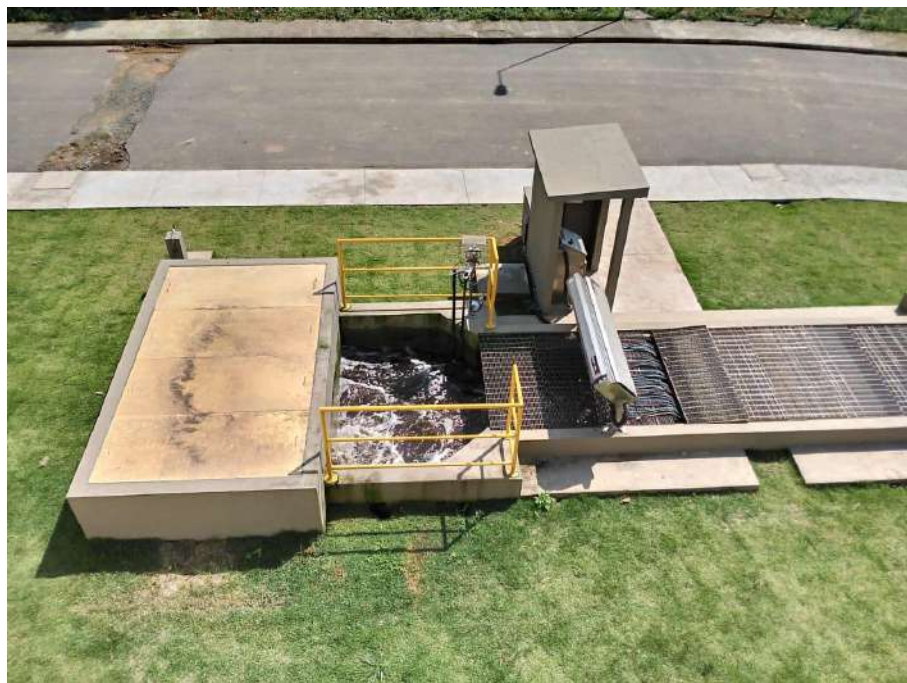
Figura 31: Unidade de desinfecção por ultravioleta
