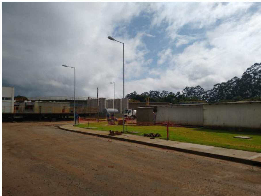
Figura 37: Elevatórias de recalque
