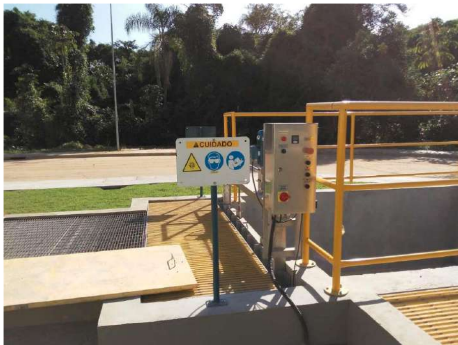
Figura 33: Unidade de desinfecção por ultravioleta
