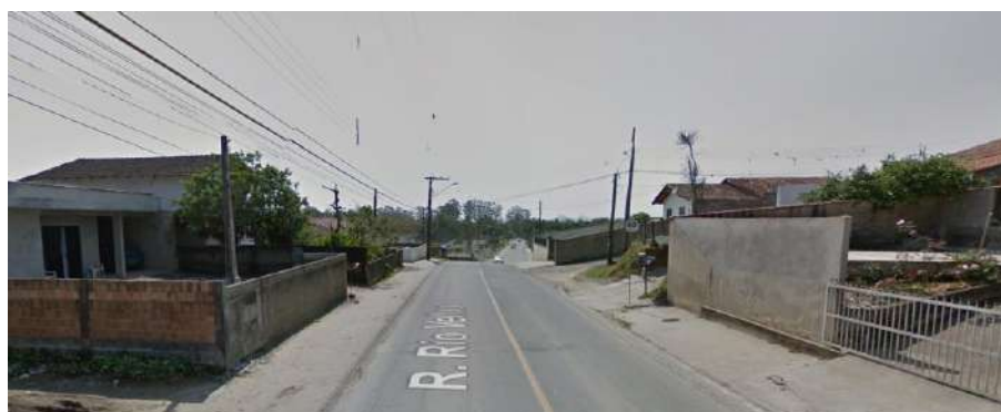
Figura 98: Iluminação pública na rua Rio Velho
