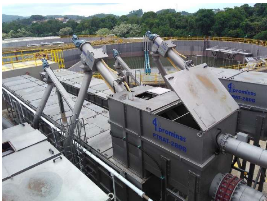
Figura 35: Unidade de tratamento preliminar
