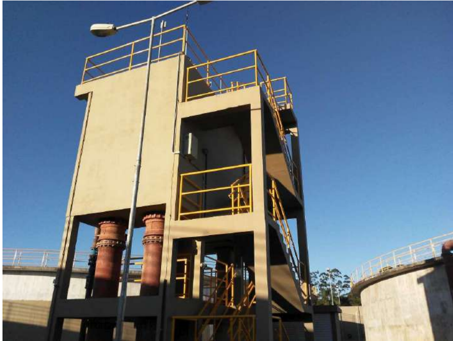
Figura 26: Tanque de distribuição
