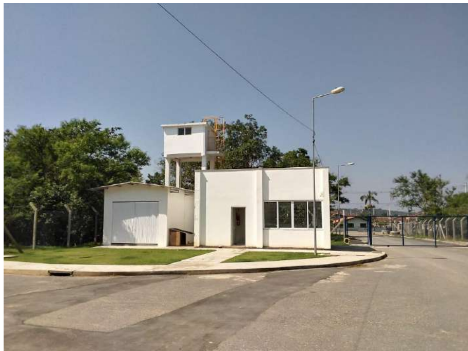
Figura 21: Guarita (estrutura à direita)
