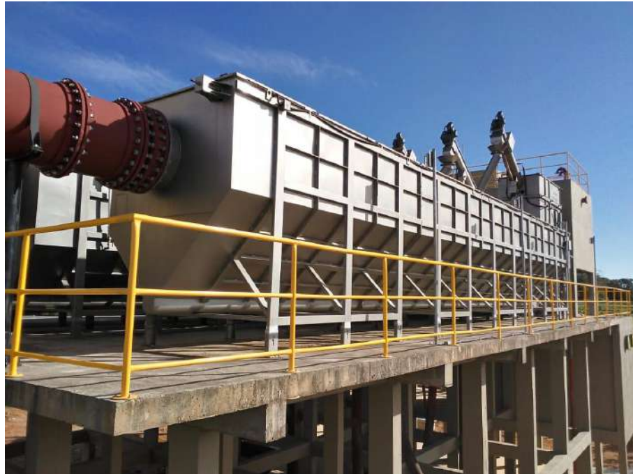
Figura 36: Unidade de tratamento preliminar
