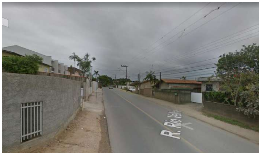
Figura 97: Iluminação pública na rua Rio Velho
