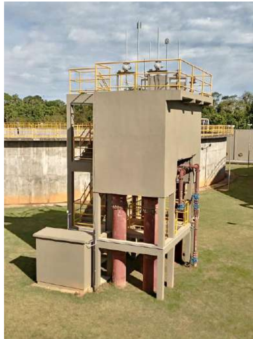
Figura 25: Tanque de distribuição
