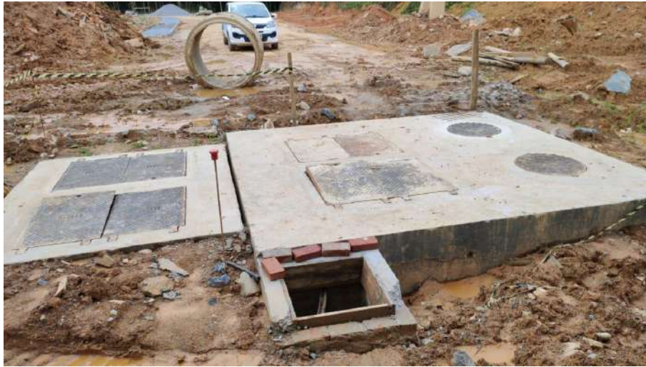
Figura 38: Elevatória de recalque
