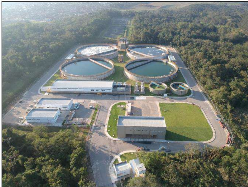
Figura 6: Foto aérea ETE Jarivatuba
