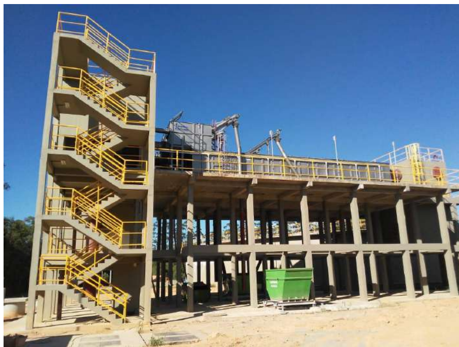
Figura 34: Unidade de tratamento preliminar
