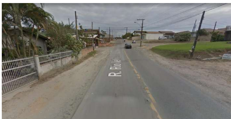
Figura 100: Pavimentação no entorno do empreendimento
