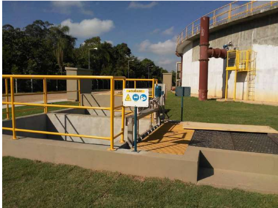
Figura 32: Unidade de desinfecção por ultravioleta
