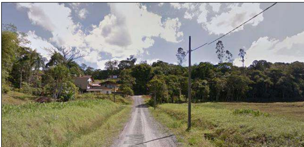
Figura 44: Rede elétrica passando pela Rua Hilda Rech (lateral do empreendimento). Fonte: Google Maps, 2015.
