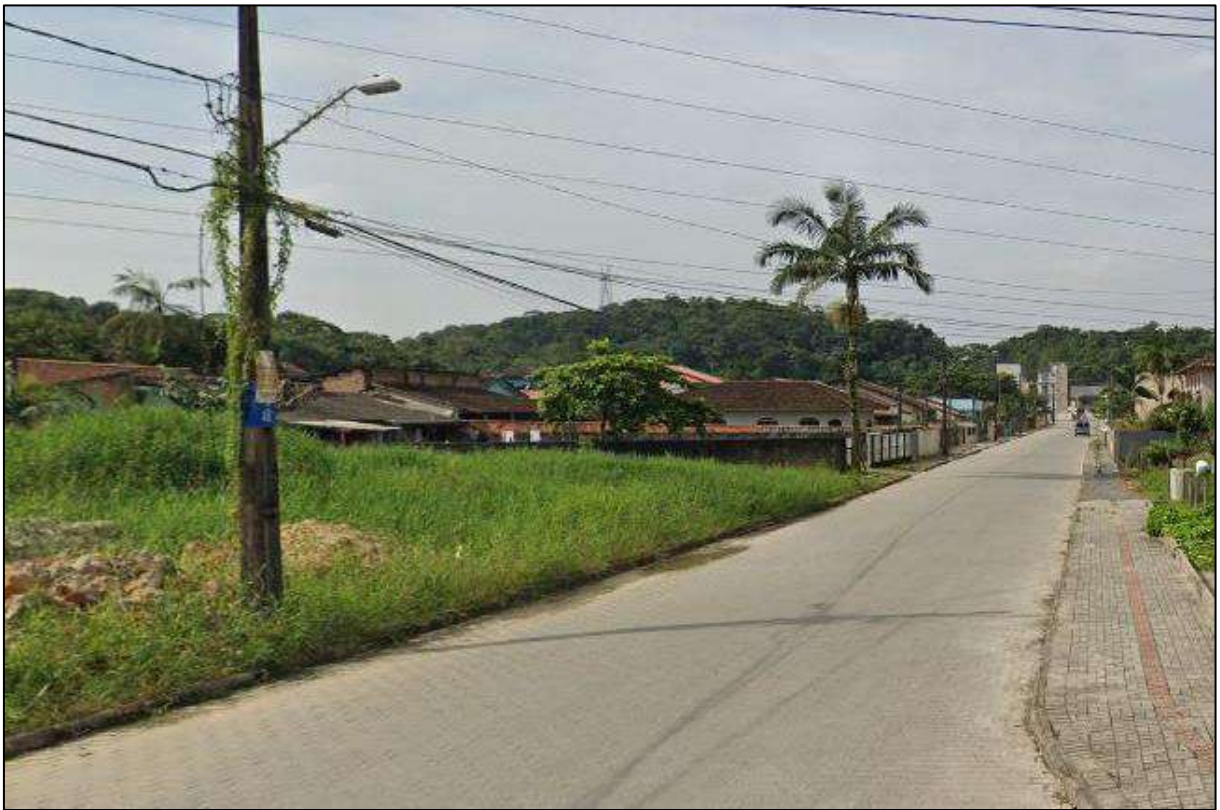
Figura 47: Prolongamento da Rua Hilda Rech pavimentada. Autor: DBio, 2021.
