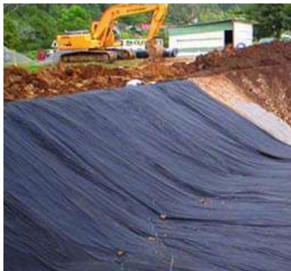
Figura 8: Exemplo do uso de geotêxtil para contenção de processos erosivos. Fonte: aecweb.com.
