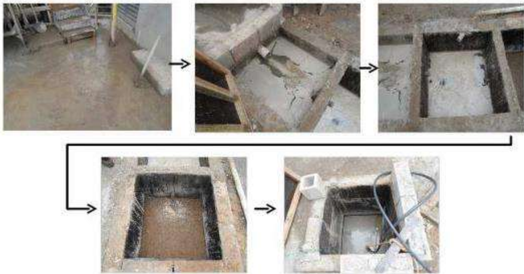
Figura 7: Exemplo de sistema de decantação em canteiro de obras. Fonte: Rosa, 2015.
