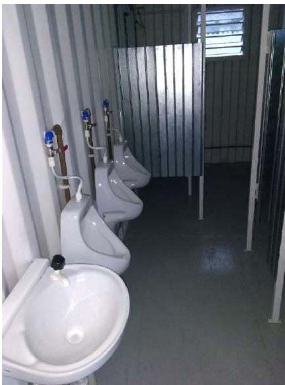
Figura 4: Container para vestiário/sanitários utilizado em outras obras da empresa ENDUTEX.
