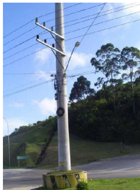
Imagem ilustrativa - Unificação da Rede Distribuição com Linha Distribuição
