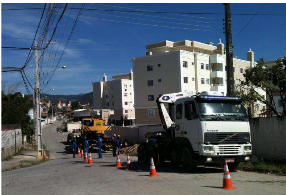
Imagem ilustrativa – sinalização e intervenção em meia pista para a montagem de estrutura.
