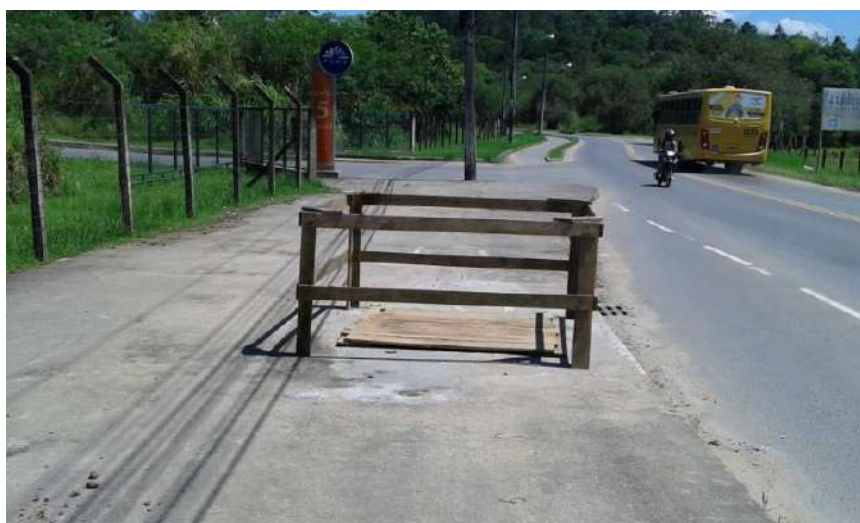
Imagem Ilustrativa – Tamponamento e cercamento da fundação.
