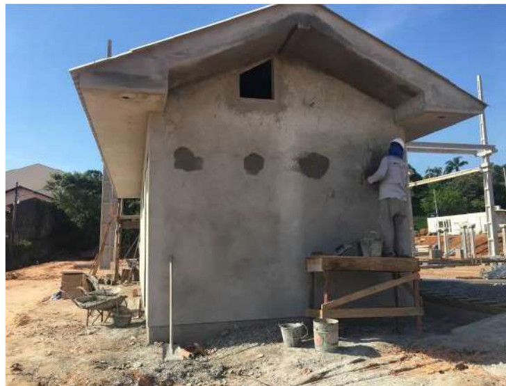
Imagem Ilustrativa – Construção da Casa de Comando.
