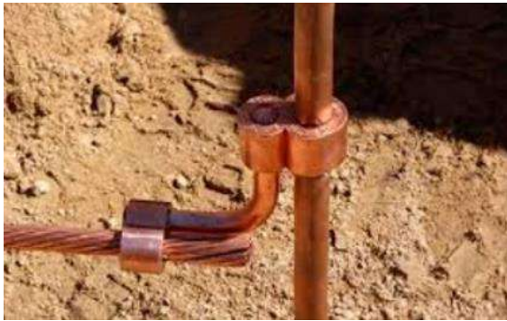
Imagens Ilustrativas – Instalação da Malha de Aterramento.
