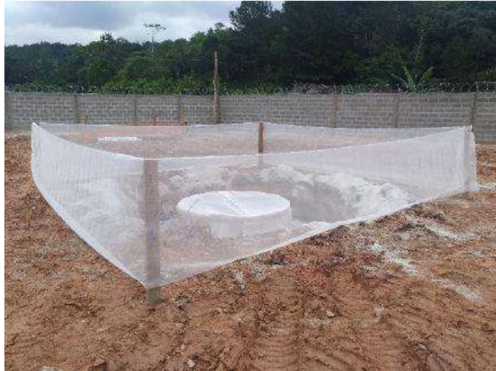
Imagem Ilustrativa – Tamponamento e cercamento da fundação.
