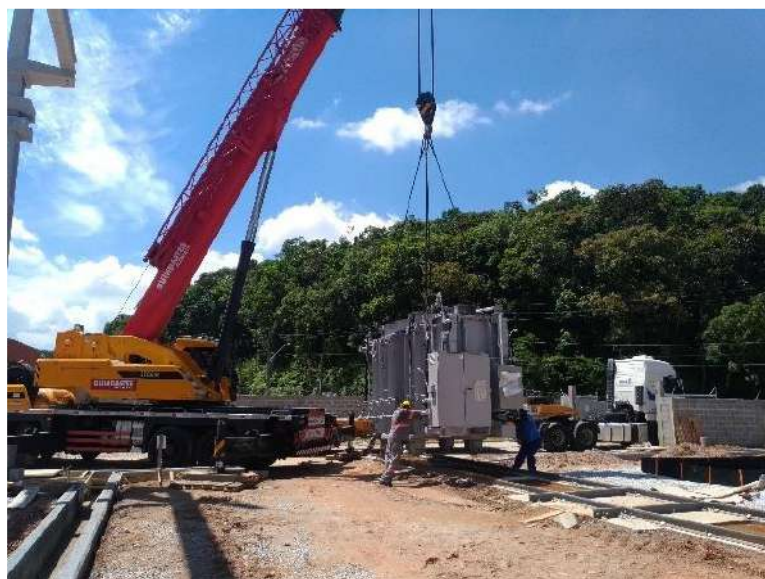
Imagem ilustrativa – içamento do transformador sobre os trilhos.
