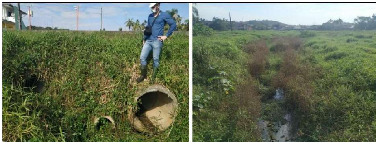
Figura 33. Início da vala de drenagem no imóvel com contribuição de água da drenagem pluvial. Fonte: DBIO, 2020.
