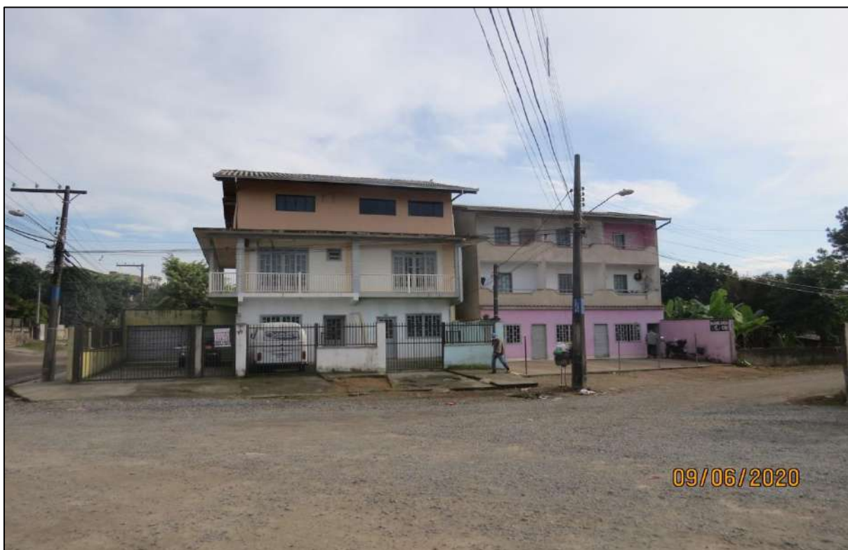
Figura 44. Empreendimento multifamiliares. Fonte: DBio, 2020.
