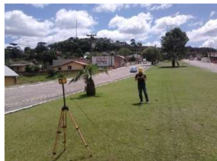
Foto 02: LT Mafra/Rio Negrinho | Circuito I Vão 179 - 180
