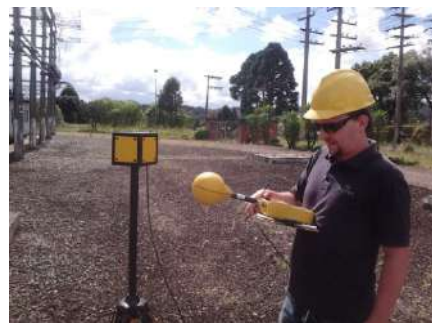
Foto 02: SE São Bento do Sul
