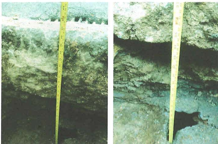
Imagens Medição in loco de diâmetro tubular do sistema de drenagem pluvial
