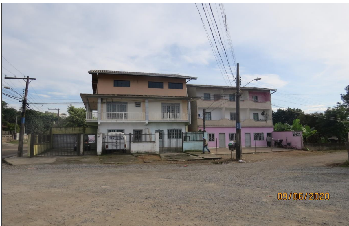
Figura 44. Empreendimento multifamiliares. Fonte: DBio, 2020.
