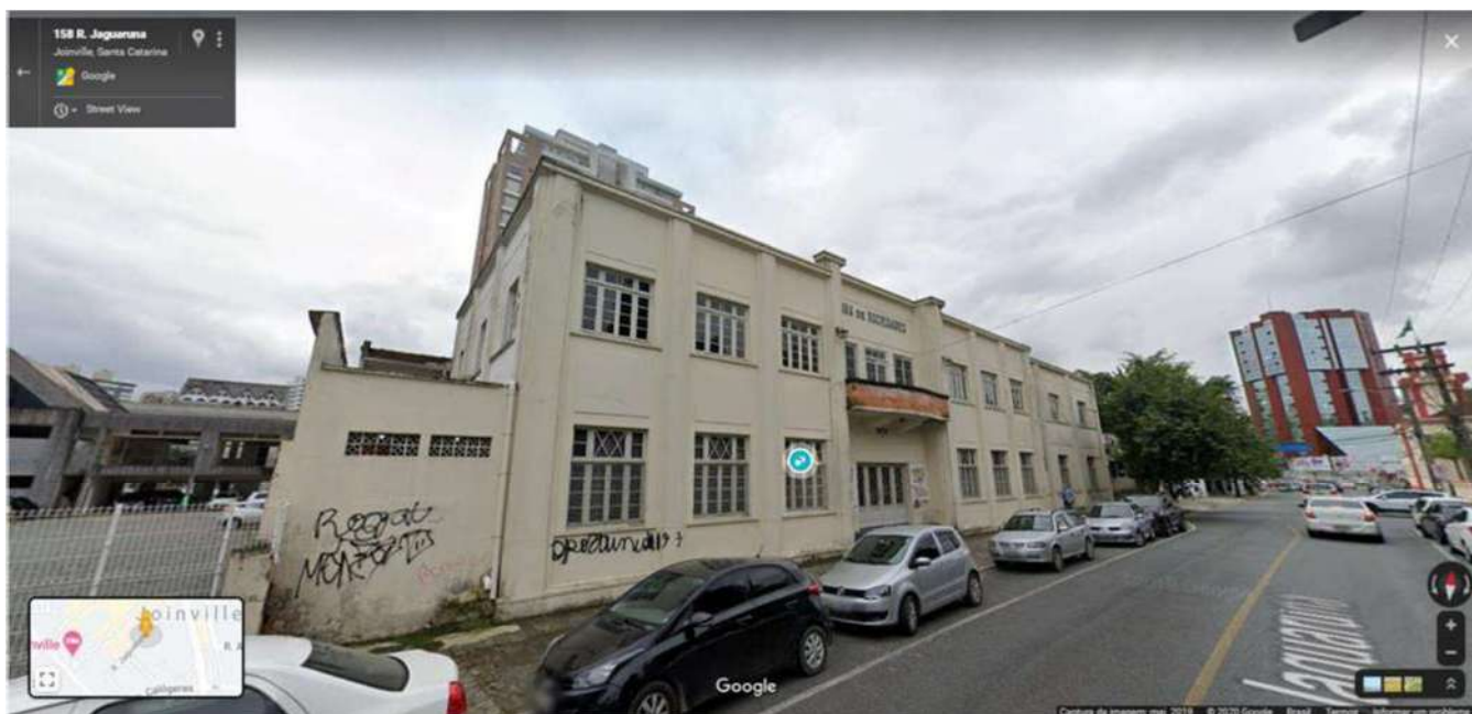
Figura 100 – Imóvel tombado, Rua Jaguaruna, 158. Fonte: Google Maps, em 12/09/2020.
