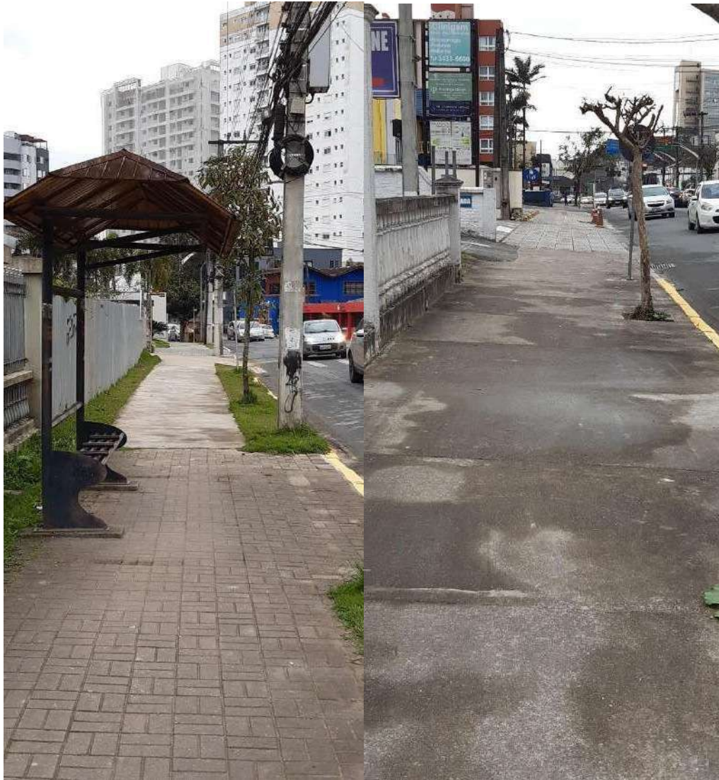
Figura 126 – Condições de deslocamento - calçadas. Fonte Google Maps, 2020.
