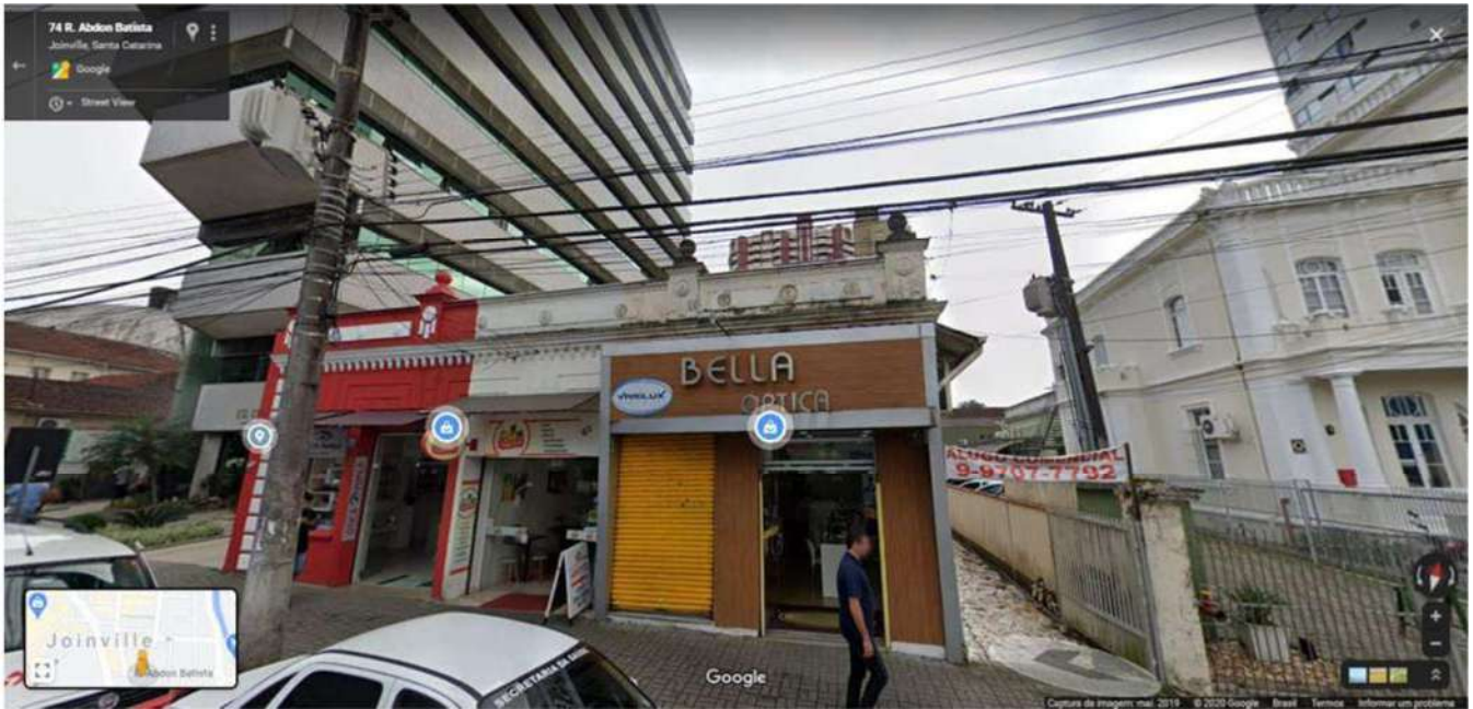
Figura 113 – Imóvel tombado, Rua Abdon Batista, 74.
