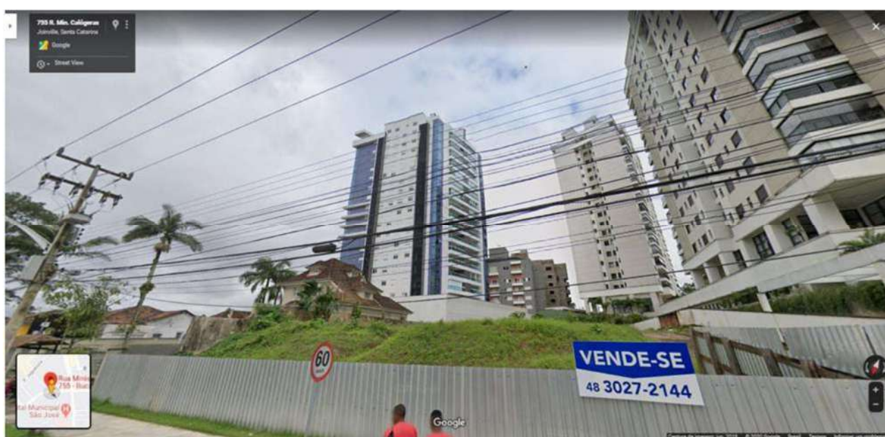
Figura 82 - Registro da rede de energia elétrica em frente ao imóvel.
