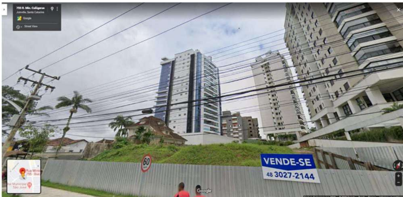
Figura 4 – Localização do empreendimento Fonte: Google Street View.
