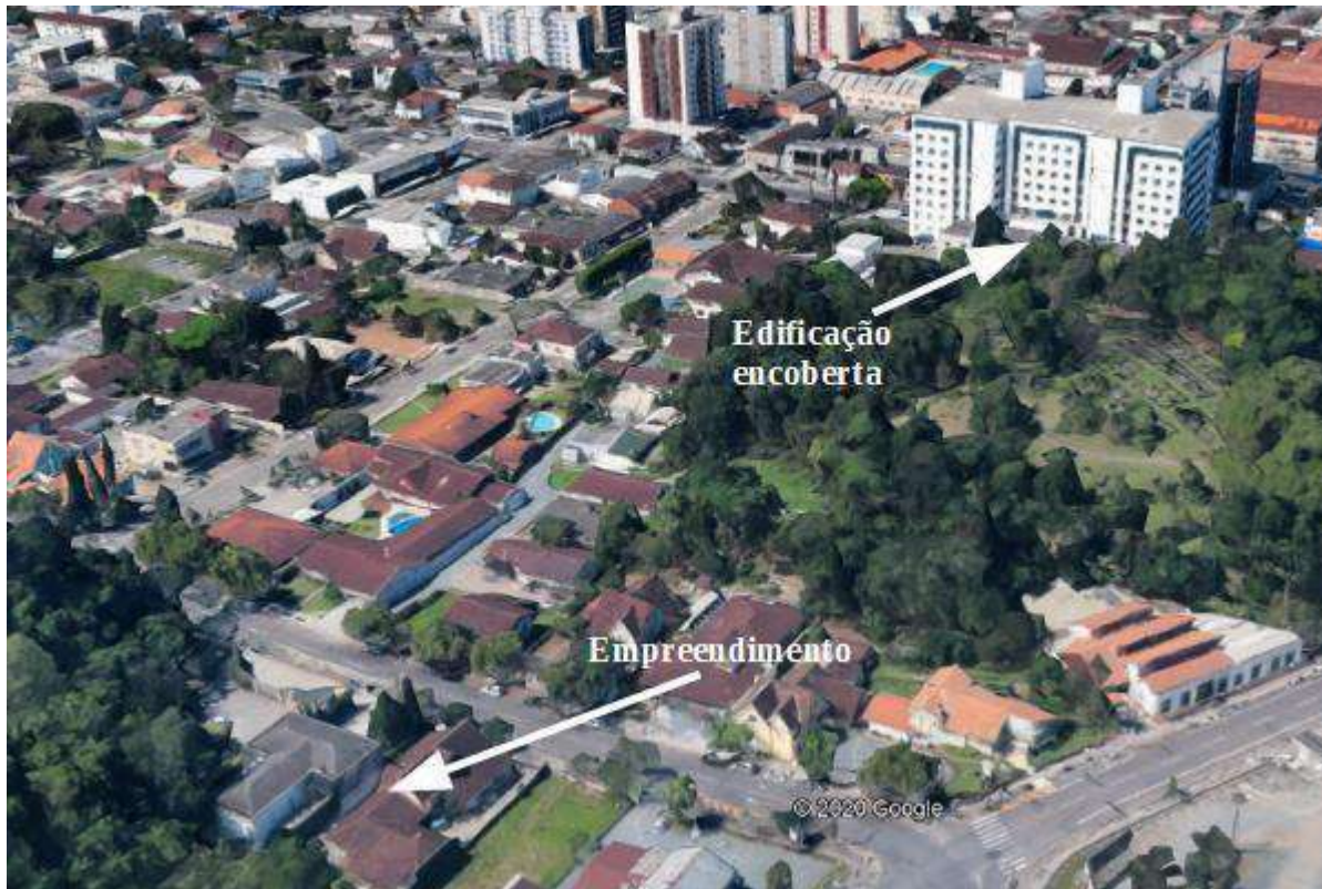
Figura 78 - Edificação encoberta pela elevação do relevo. Fonte: Google Earth.
