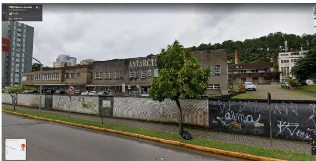
Figura 145 – Imóvel tombado, Quinze de Novembro, 1420 – Complexo Cidalela Antártica Fonte: Google Maps, em 13/08/2020.
