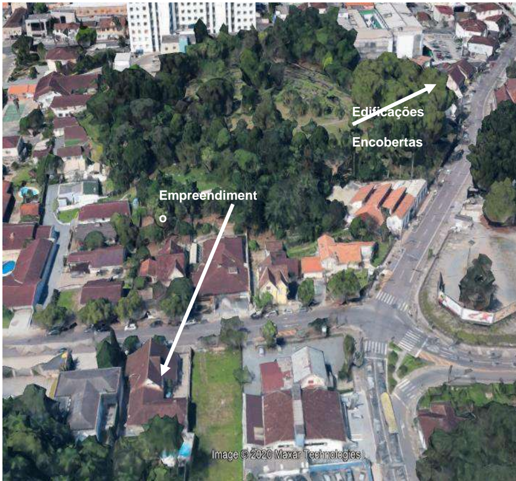
Figura 65 - Edificações encobertas pela elevação do relevo. Fonte: Google Earth.
