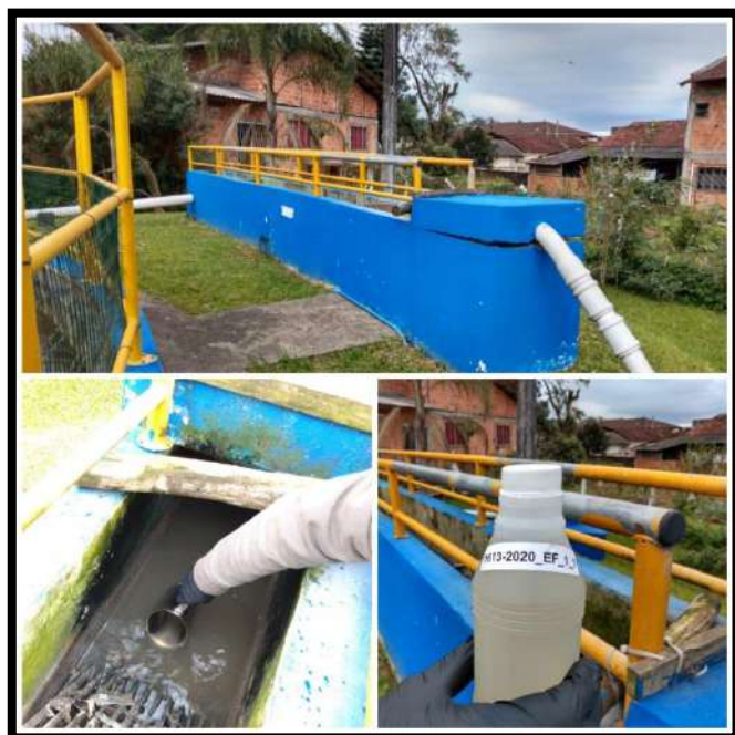
Entrada ETE Profipo
