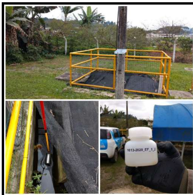
Saída ETE Profipo
