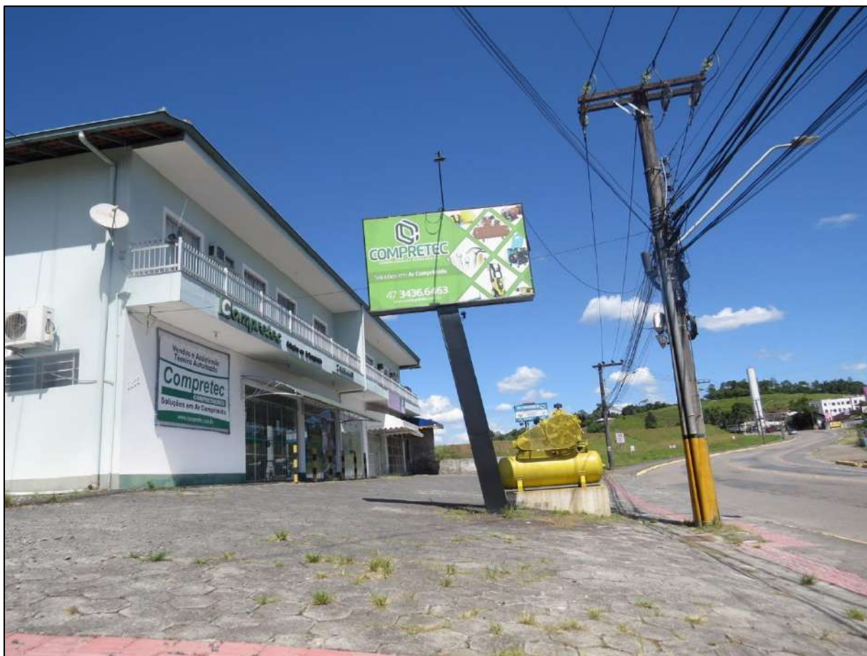
Figura 59. Rede elétrica passando pelo imóvel em estudo. Autor: DBio, 2020.
