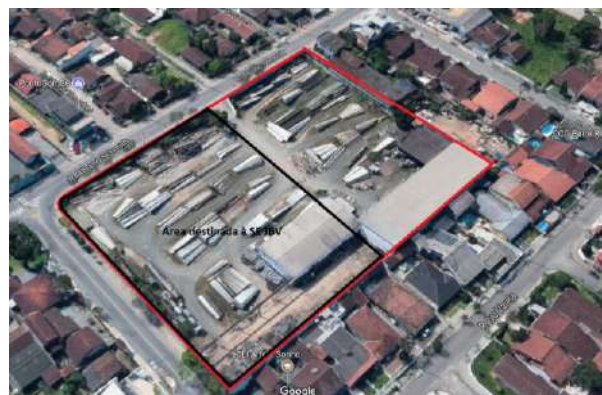
Figura 1: Vista geral do terreno da subestação.
