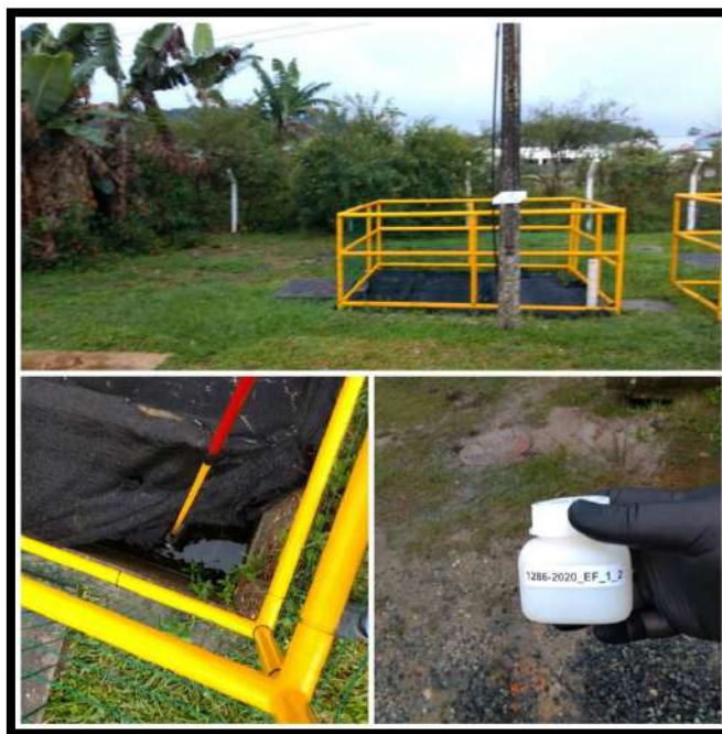
Saída ETE Profipo
