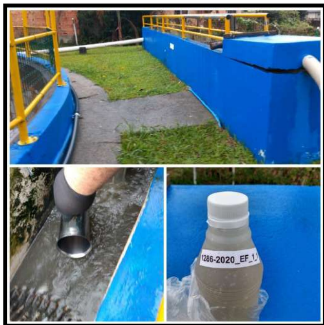
Entrada ETE Profipo
