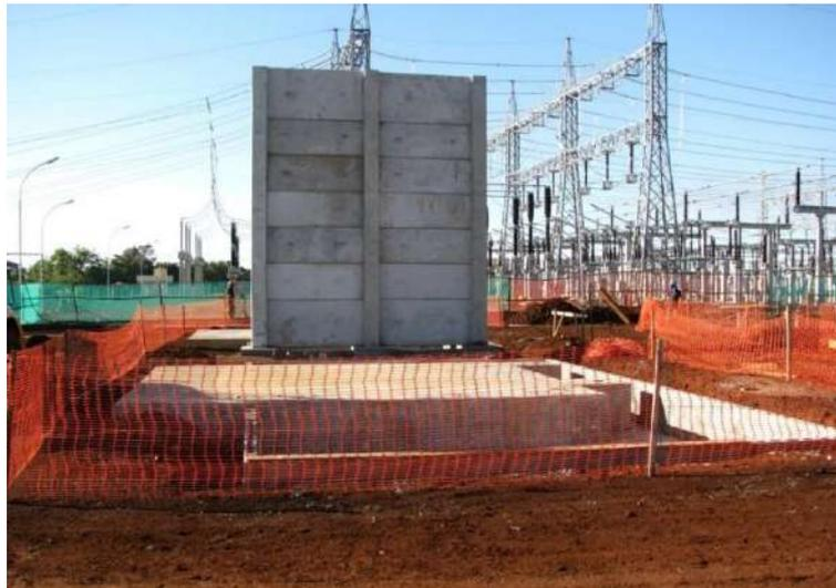
Figura 4: Exemplo de Subestações já instaladas, detalhando as paredes contrafogo e bacia de contenção de óleo na base de transformadores.
