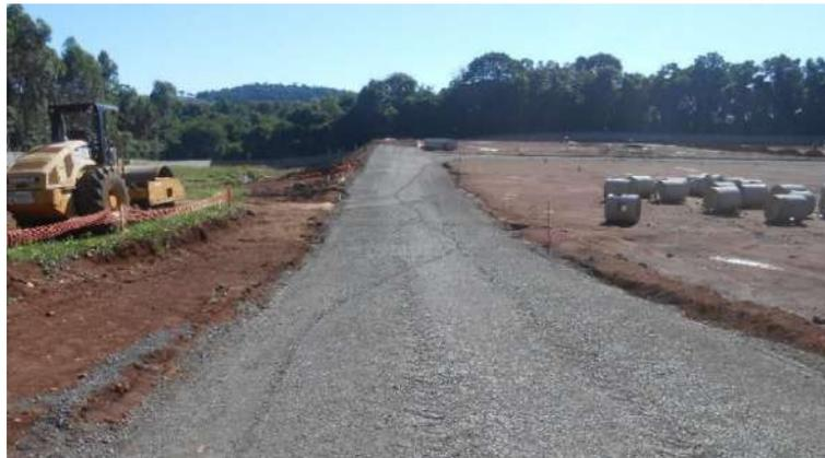
Figura 2: Vista de implantação de arruamento em subestação.
