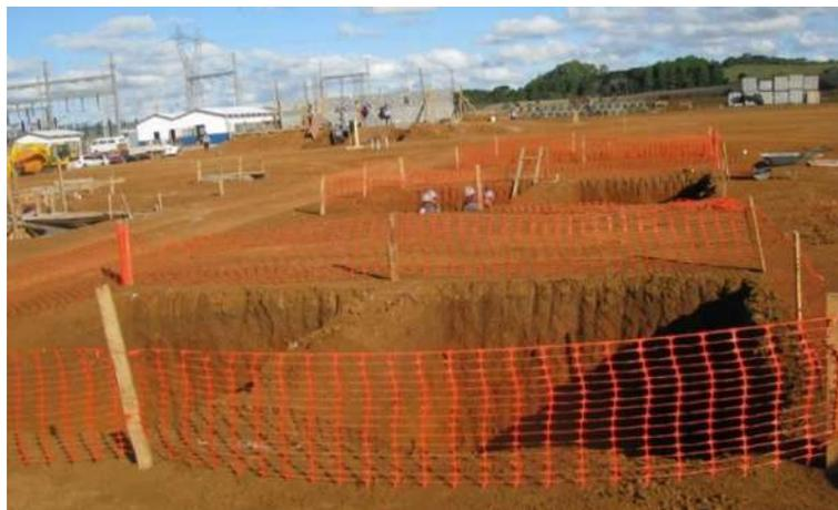
Figura 3: Exemplo de atividades iniciais de escavação para fundações e locação de estruturas.
