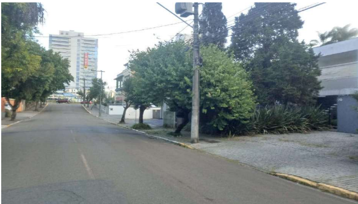
Figura 63 - Registro da rede de energia elétrica em frente ao imóvel.
