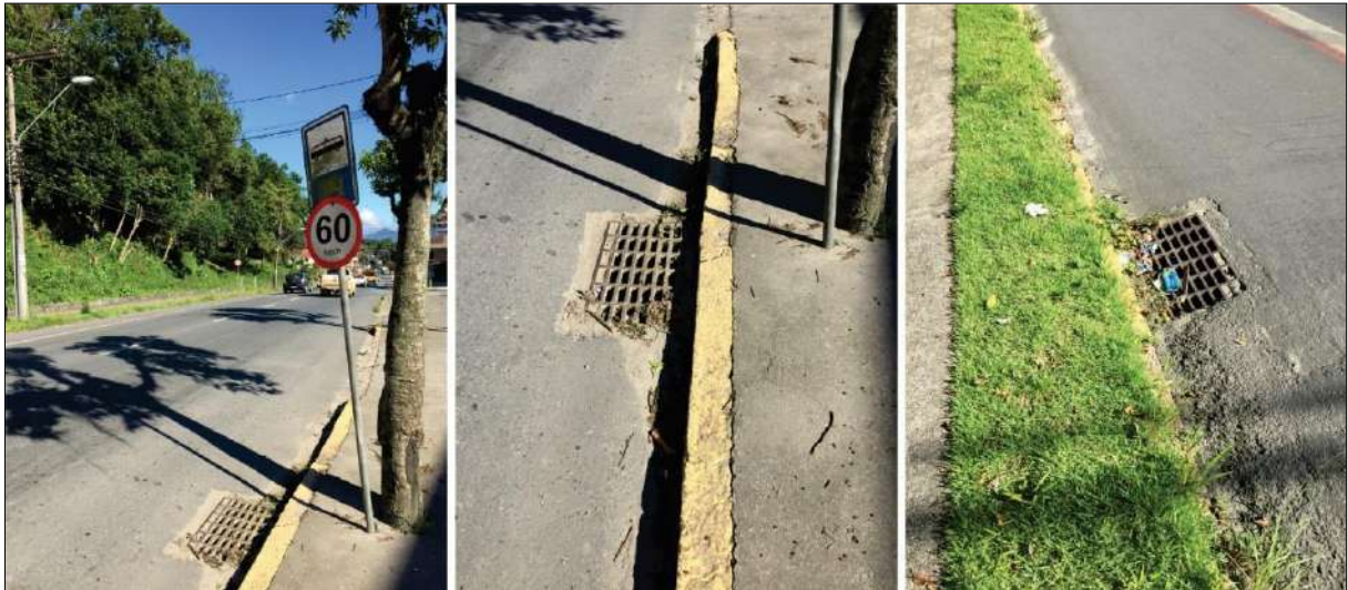
Figura 64: Drenagem pluvial rua Tenente Antônio João. Fonte: Acervo Pessoal.
