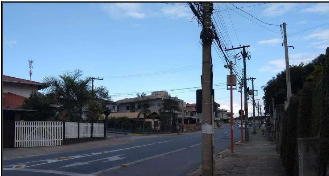
Figura 59: Instalação de rede de telefonia próxima ao empreendimento.
