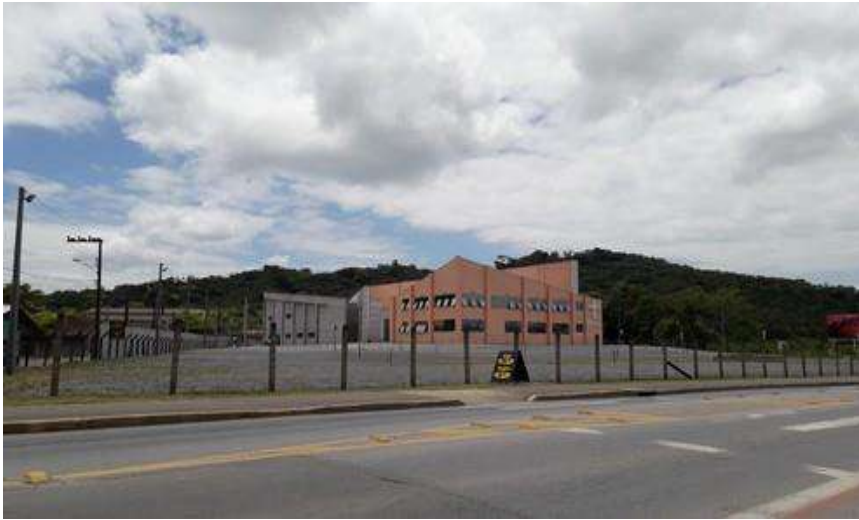
Figura 31: Santuário Santíssimo Sacramento em construção
