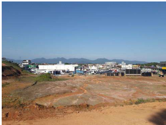
Figura 24: Terraplanagem executada conforme Alvará de Terraplanagem SEI Nº 2683218/2018
