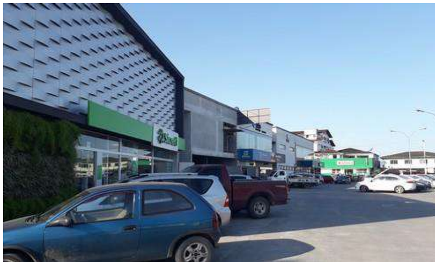
Figura 35: Salas comerciais localizadas no lado norte do terreno (Edificação 02 e 03)
