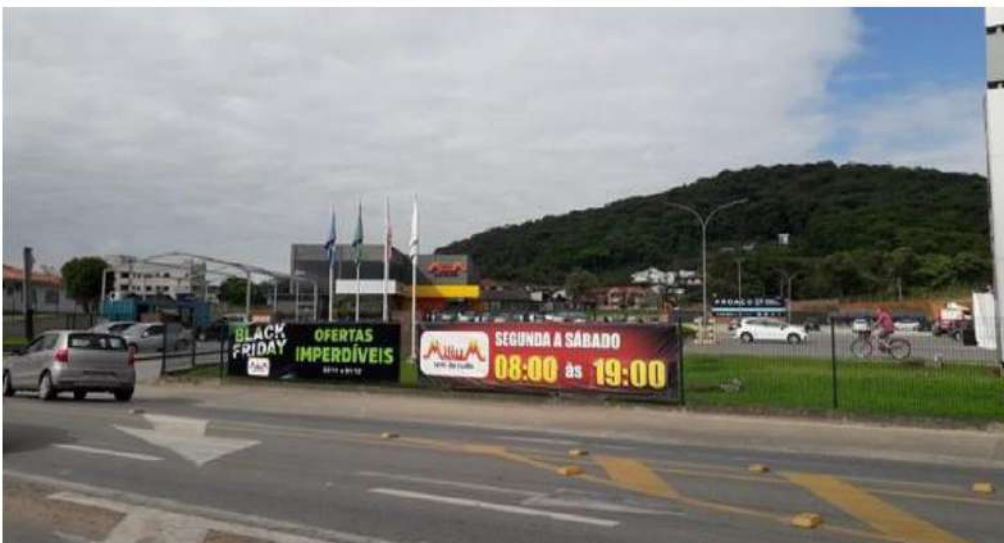
Figura 41: Maciço verde ao fundo prevalecendo já com as edificações existentes
