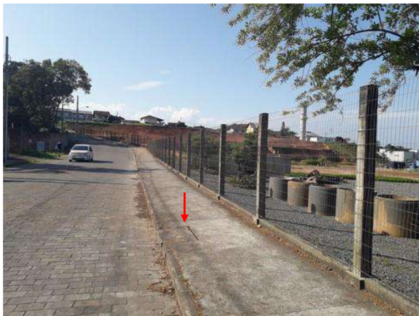
Figura 25: Boca de lobo em drenagem existente na rua das Flores
