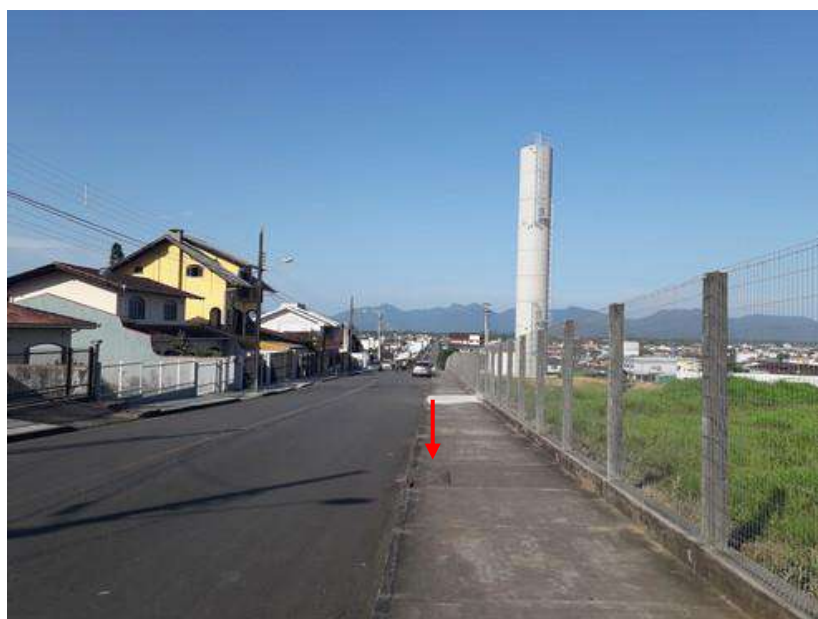
Figura 26: Boca de lobo em drenagem existente na rua Bonito Lindo
