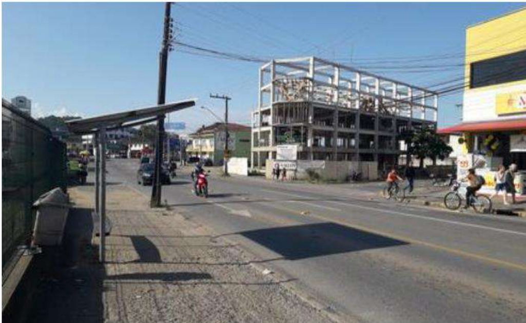
Figura 51: Abrigo de passageiros do SIT na rua Tuiuti para linhas sentido Estação Iriú
