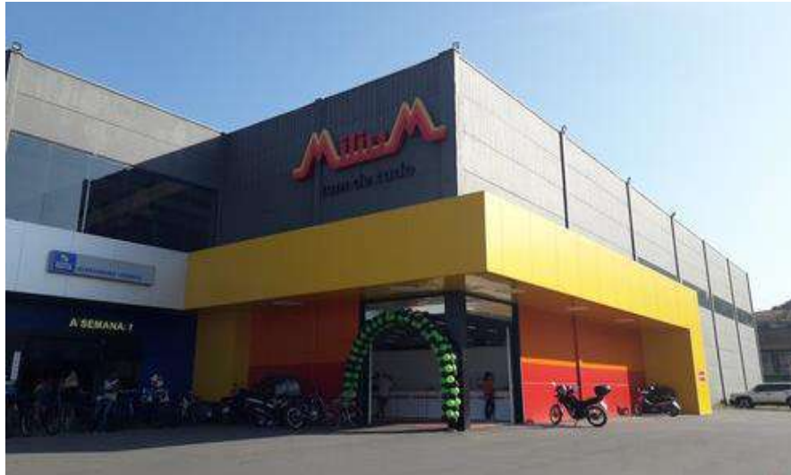
Figura 36: Edificação localizada no lado sul do lote (Edificação 04)
