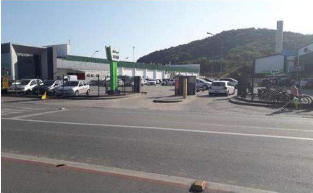
Figura 49: Ausência de piso tátil nas áreas vulneráveis aos PCD
