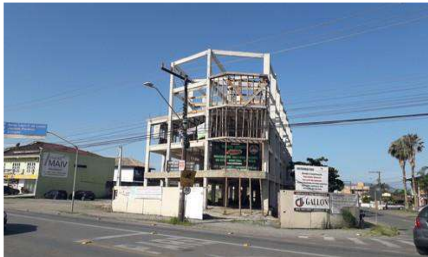
Figura 29: Nova edificação de uso comercial em construção
