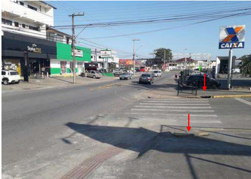
Figura 27: Boca de lobo em drenagem existente na interseção das ruas Tuiuti e Bonito Lindo
