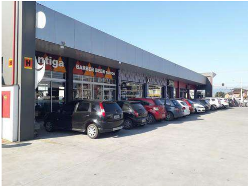
Figura 34: Salas comerciais adjacentes ao Supermercado Rodrigues (Edificação 02)
