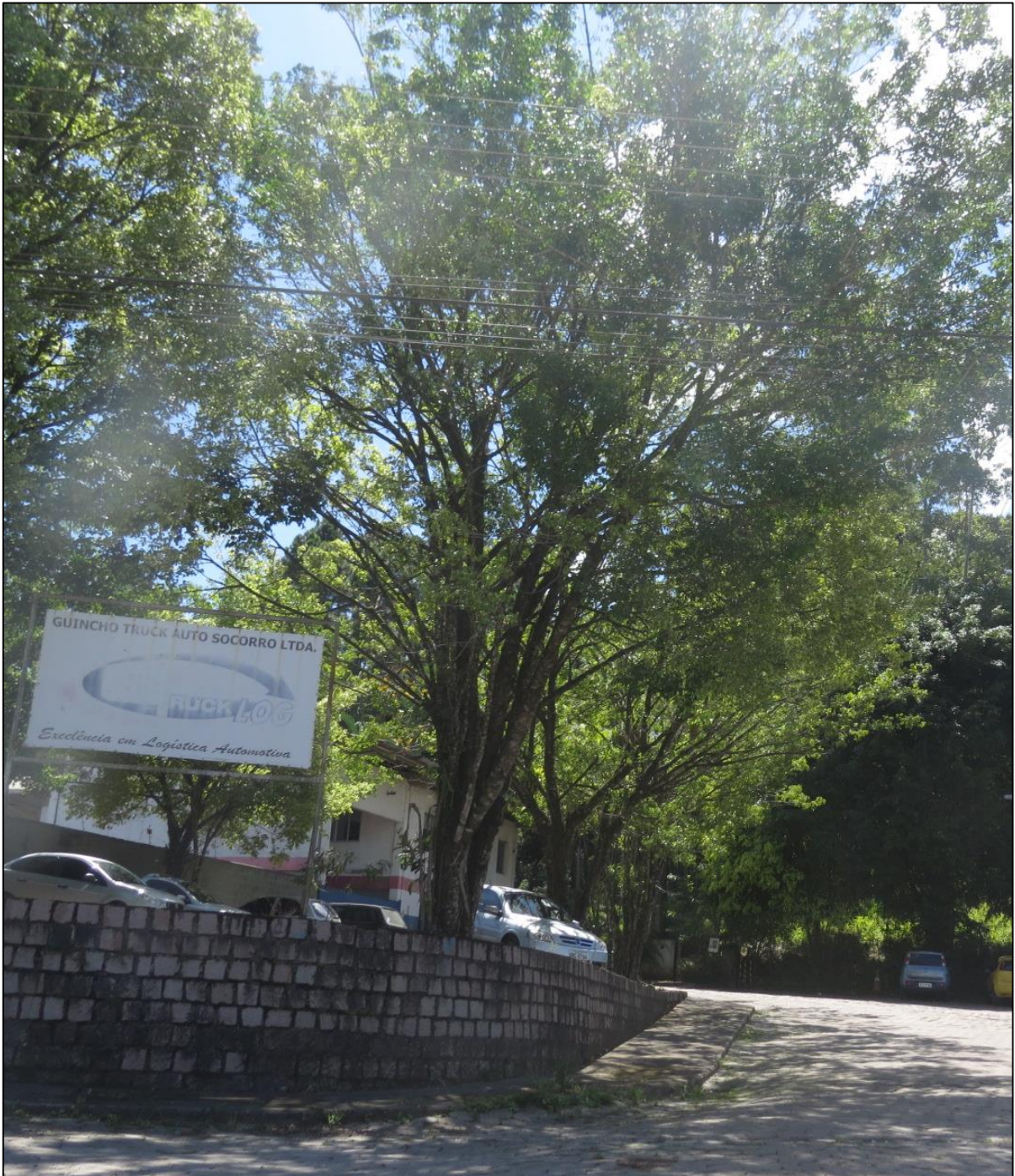
Figura 7. Vista do imóvel do presente Estudo em seu uso atual. Fonte: DBio, 2020.
