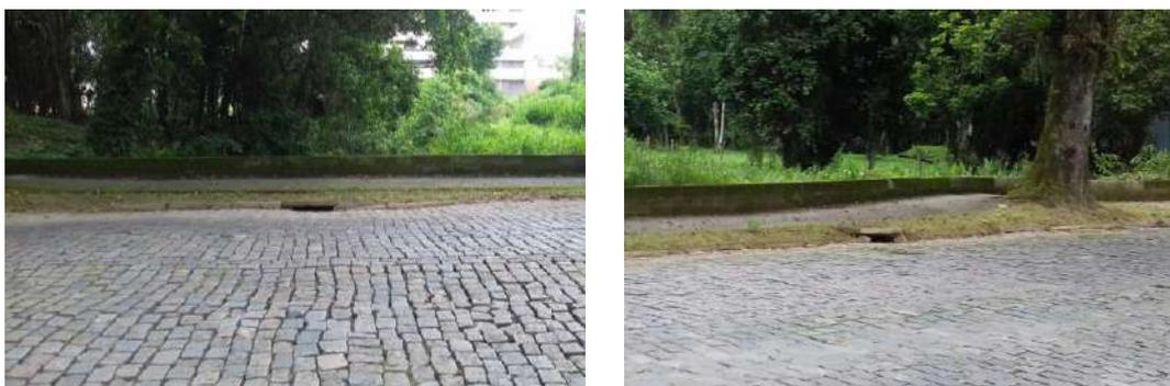
Figura 94. Caixas de saída da água pluvial.
