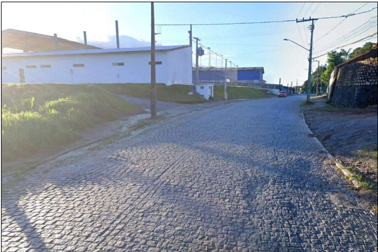
Figura 68: Rua Copacana, calçamento. Fonte: DBio, 2020.
