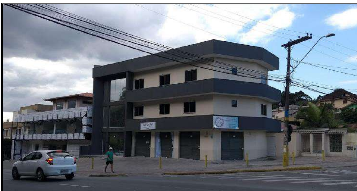
Figura 45: Edifício residencial e comercial próximo ao empreendimento na Rua Tenente Antônio João. Foto: Acervo pessoal.
