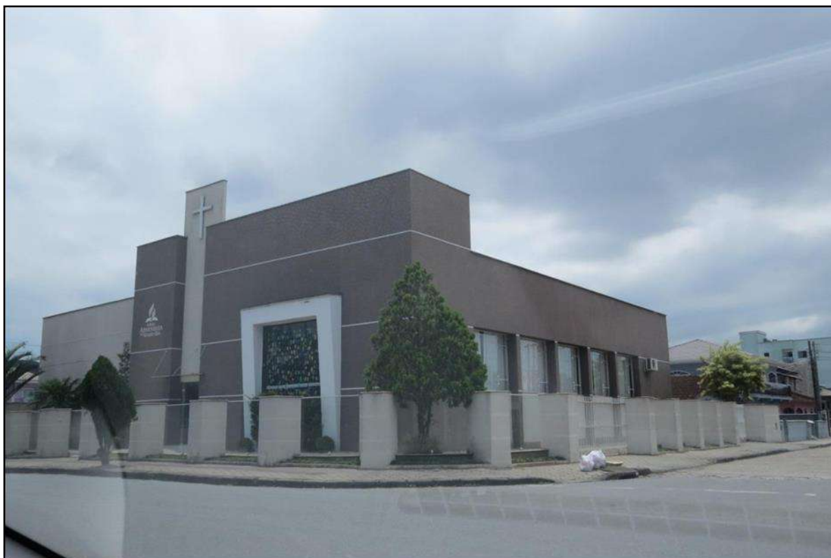
Figura 37. Condomínio residencial/religioso. Autor: DBio, 2019.
