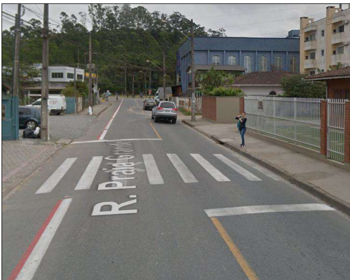
Figura 34. Rua pavimentada de acesso ao empreendimento. Autor: DBio, 2019.
