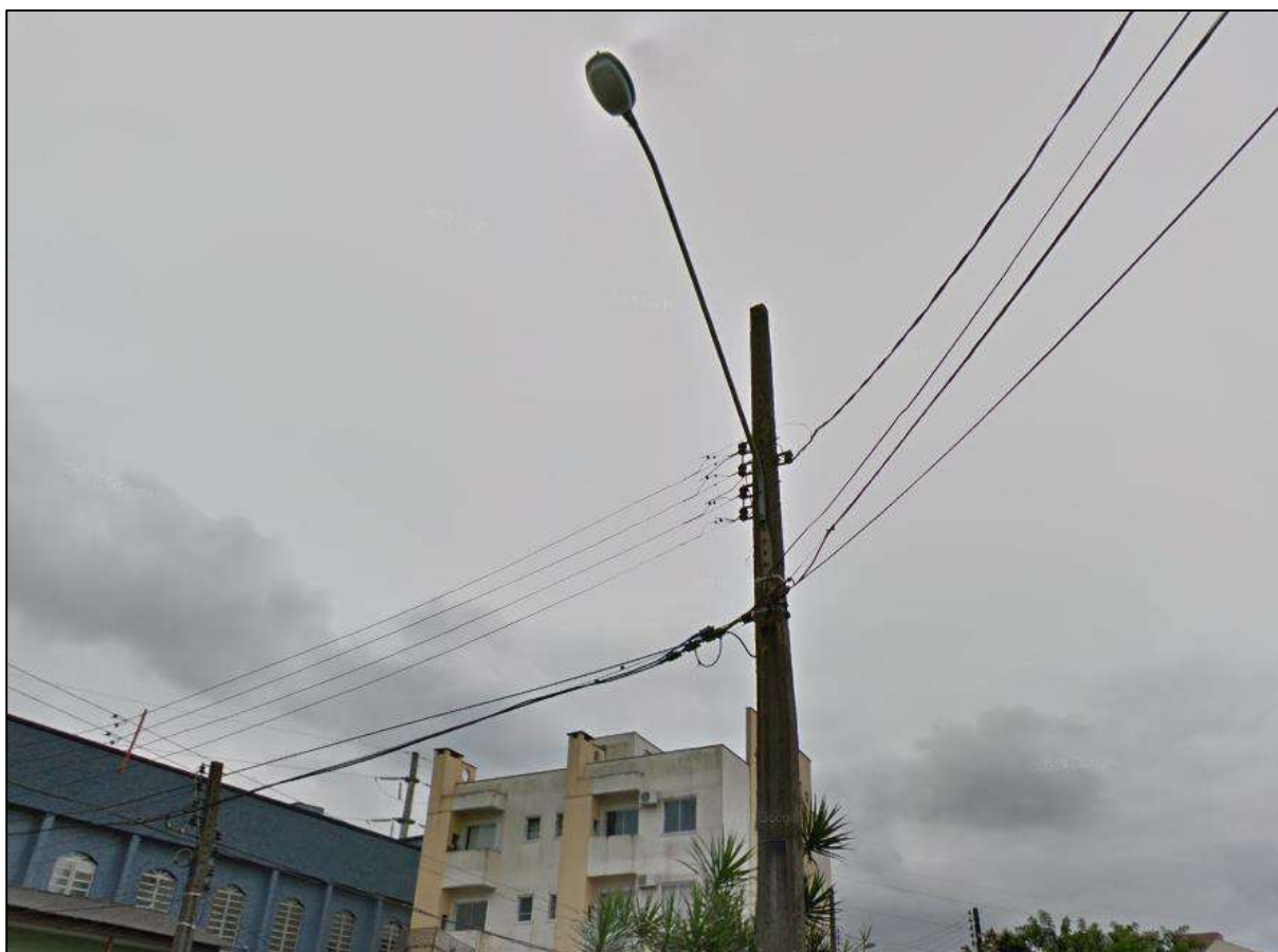
Figura 33. Rede elétrica passando pelo imóvel em estudo. Autor: DBio, 2019.
