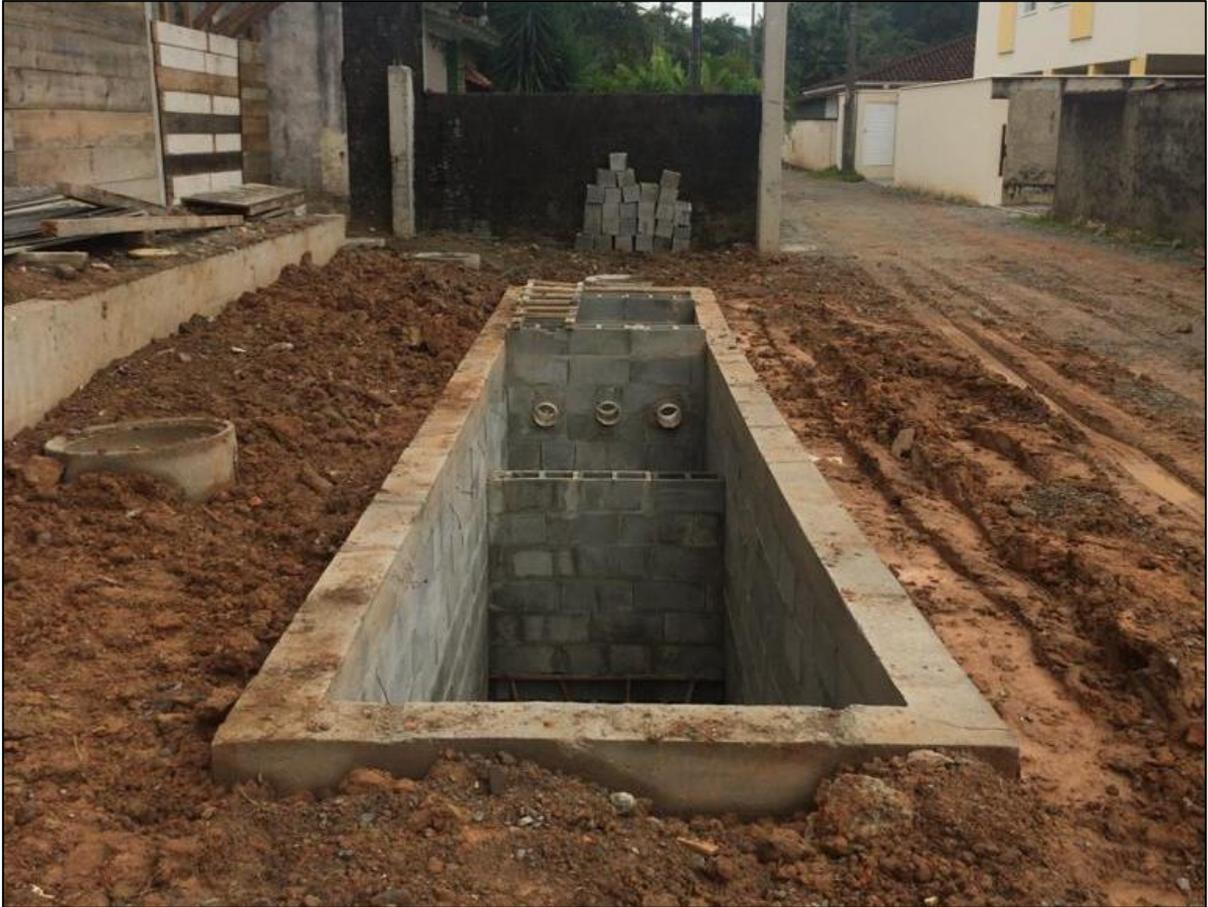
Figura 39. ETE- estação de tratamento de esgoto. Autor: DBio, 2020.
