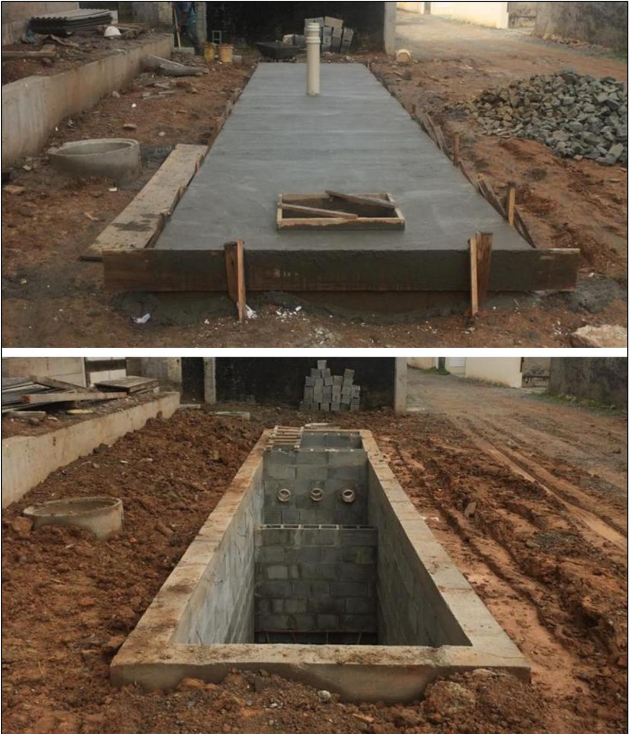
Figura 48. ETE - Estação de tratamento de esgoto do empreendimento. Autor: DBio, 2020.
